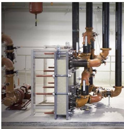
Obrázok č. 48 Doskový výmenník s napojením potrubného systému Vitaallic [31]
