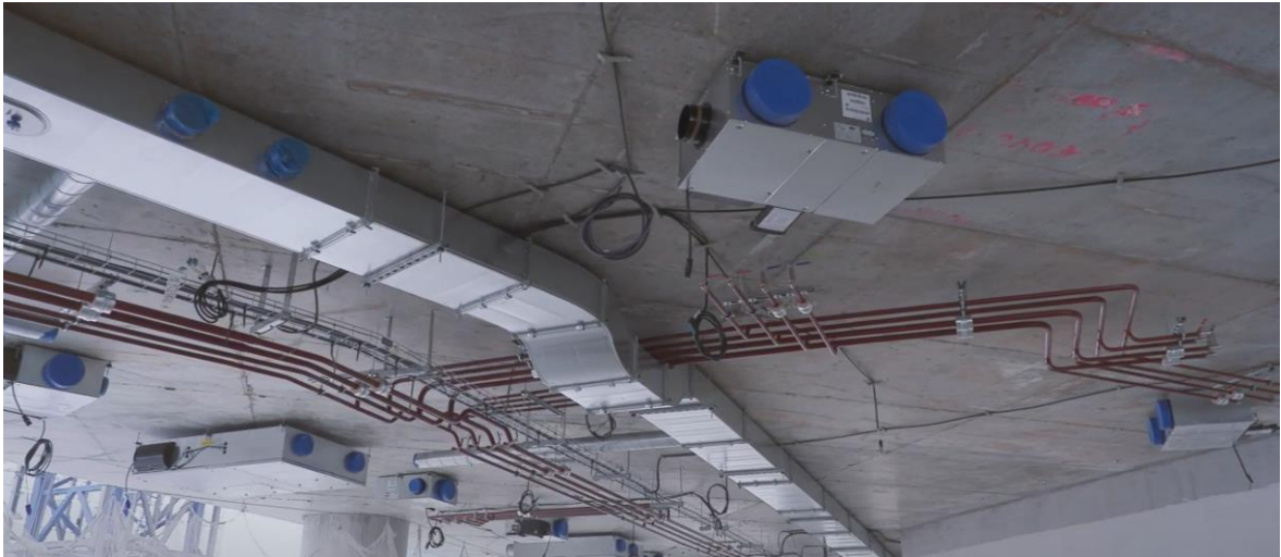
Obrázok č. 32 Rozmiestnenie decentralizovaných vzduchotechnických a cirkulačných jednotiek [24]
