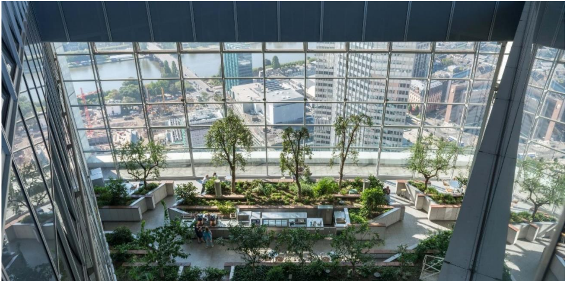
Obrázok č. 25 Priestor využívaný pre nasávanie a výfuk, ako hlavný prvok systému prirodzeného vetrania [3]
