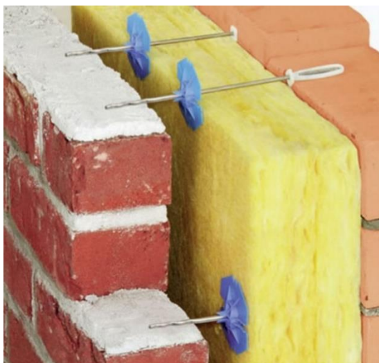
Obrázek 10 - Řešení s lícovými cihlami [11]
