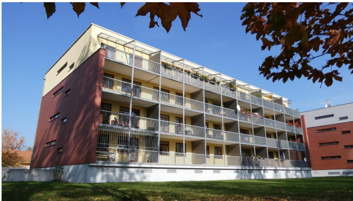
Obrázek 4 - Řešený bytový dům: JZ pohled [7]
