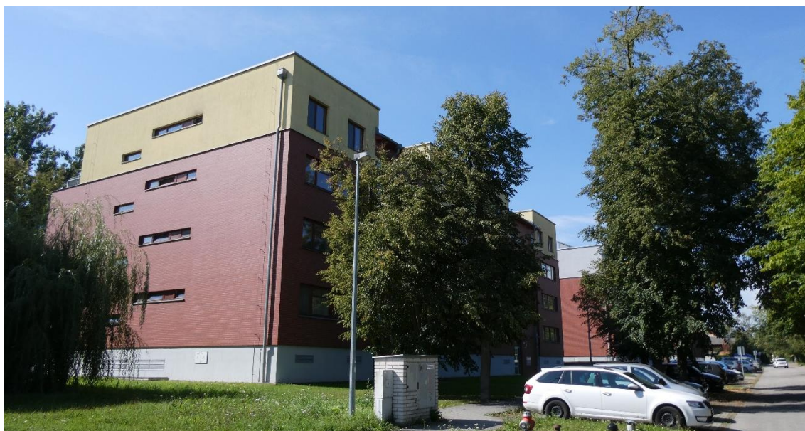
Obrázek 5 - Řešený bytový dům: SV pohled [7]
