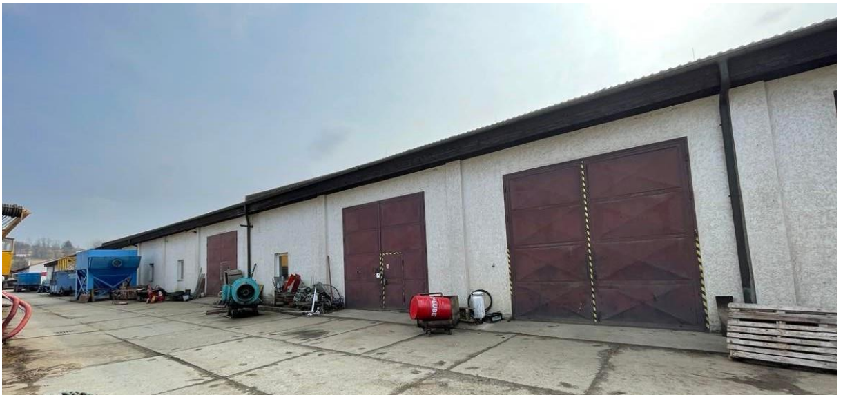
Obrázek 9 - Pohled na objekt haly
