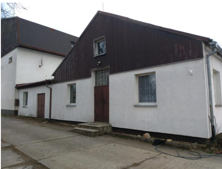
Obrázek 8 - Pohled na objekt truhlárny
