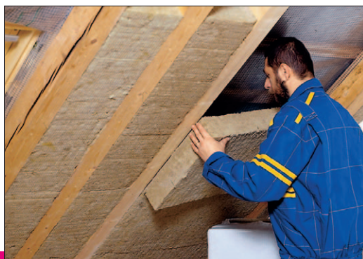
Ukázka aplikace výrobku ISOVER Uni
