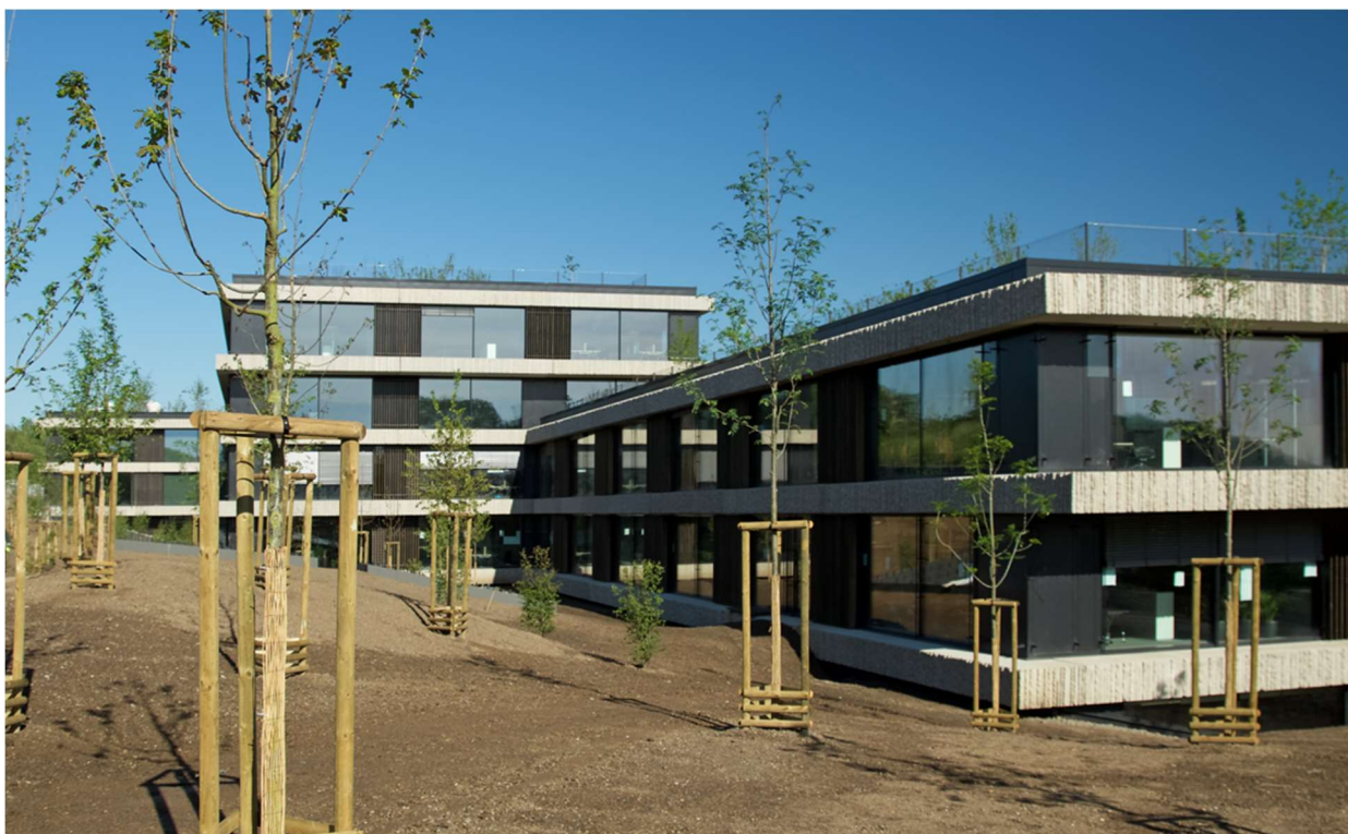
Obr. 23: Pohled na vybranou budovu [39]
