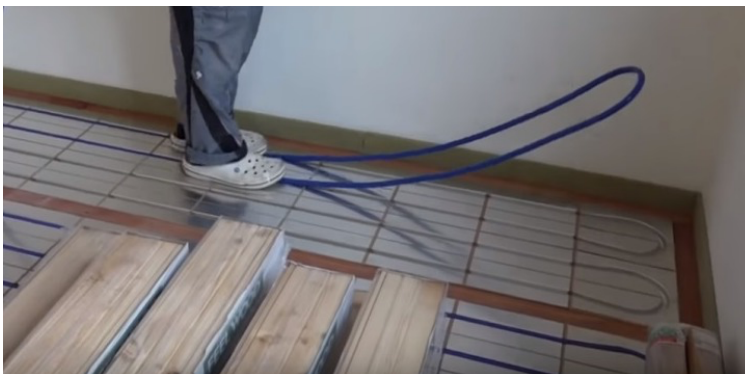
Obrázek 6: Příklad realizace suchého systému [20]
