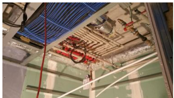
Obrázek 29: Montáž rozdělovače topné a chladicí vody v podhledu [30]
