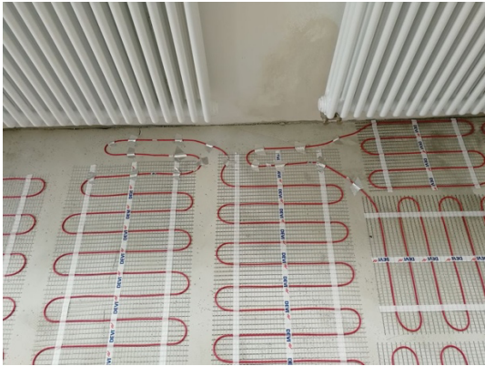
Obrázek 26: Topné kabely na rohoži pokládáné v pásech [17]
