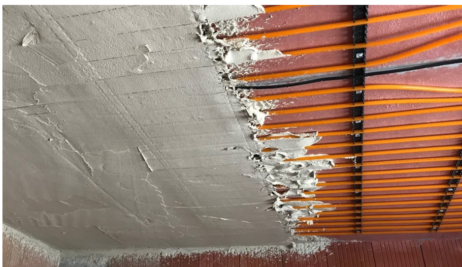
Obrázek 14: Stropní vytápění/chlazení – mokrý způsob [25]
