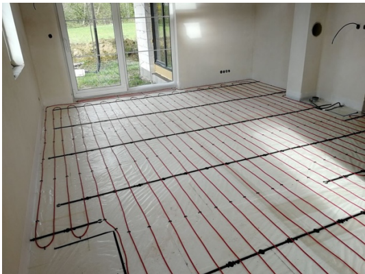
Obrázek 27: Topné kabely ukládané do vodících lišt [18]
