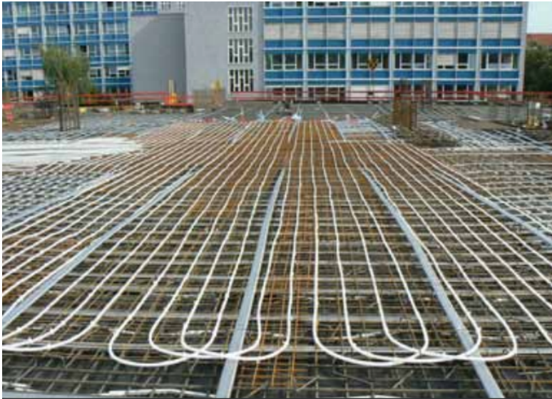
Obrázek 31: Pokládka potrubního systému do betonového jádra [32]
