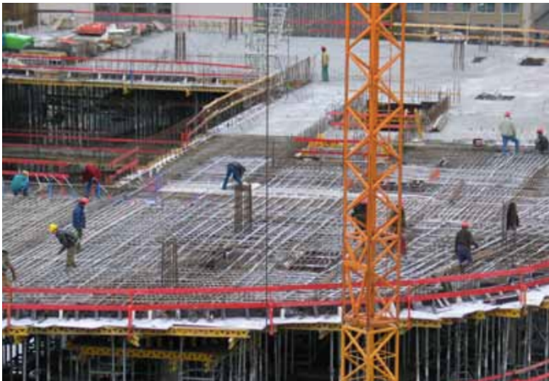
Obrázek 32: Pokládka potrubního systému do betonového jádra - 2. etapa [32]
