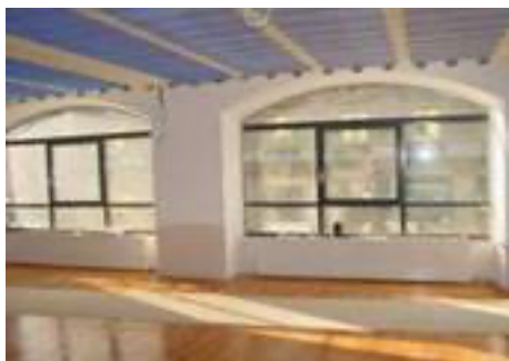
Obrázek 19: Kap. rohože – stropní vytápění/chlazení [15]
