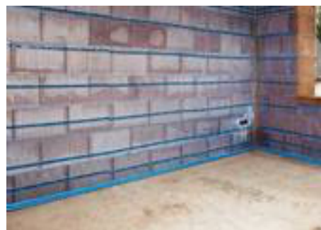
Obrázek 18: Kap. rohože – stěnové vytápění/chlazení [15]
