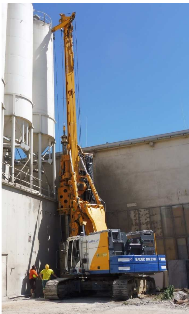
Obr. 39 Práce vrtné soupravy ve stísněných podmínkách [archiv Čeněk a Ježek a.s.]
