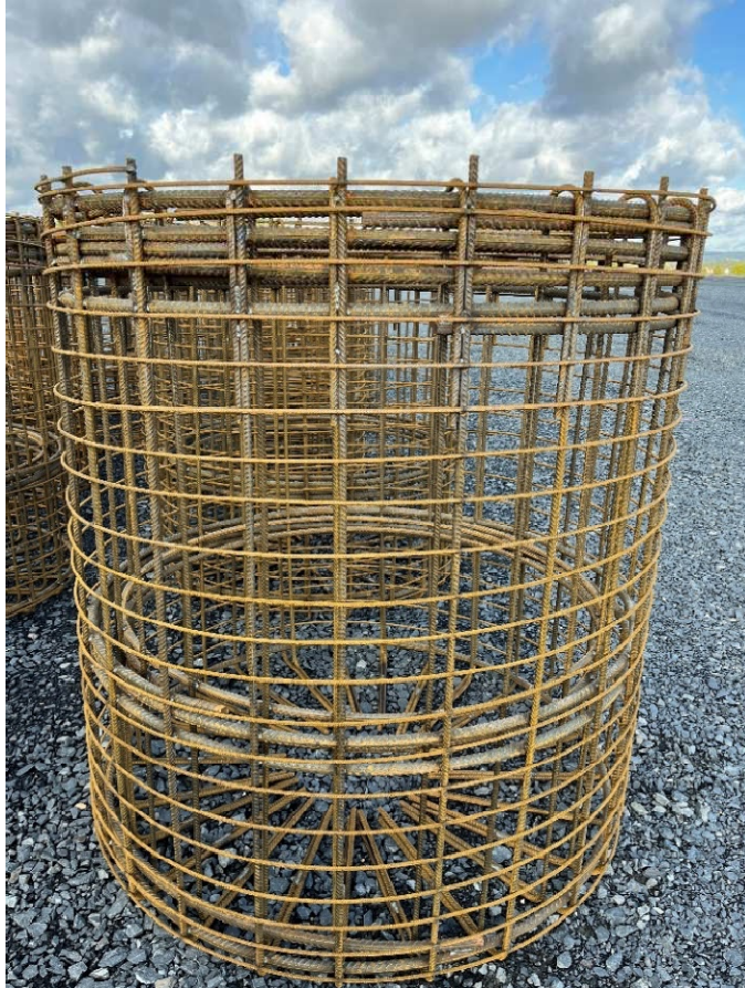
Obr. 29 Výztuž vrtané hlavice [autor]
