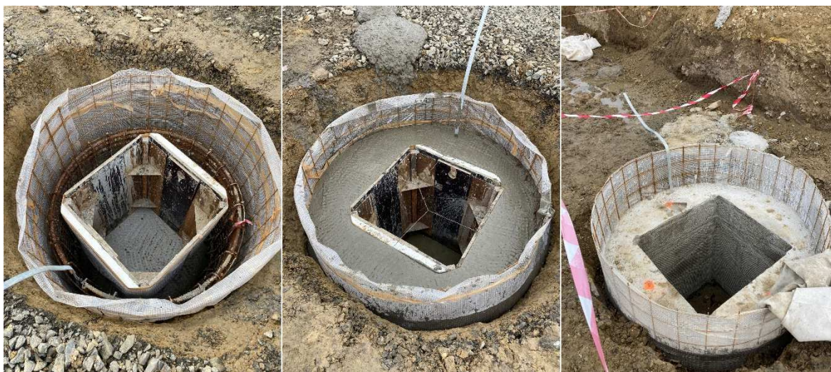
Obr. 26 Výroba vrtané hlavice [archiv Čeněk a Ježek a.s.]
