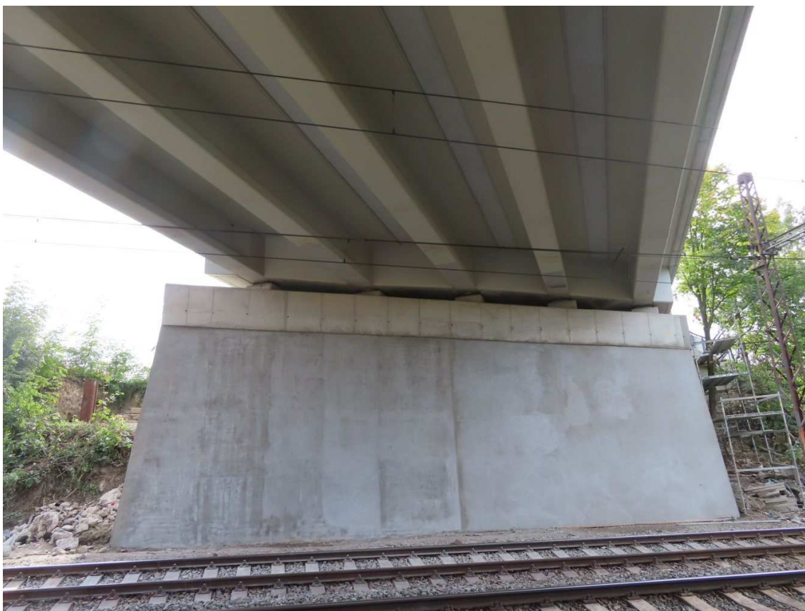
Obrázek 2.2: Příklad nadpodporového příčnicku trémového mostu (most Y-502 v Praze; 1. HPM, 5. 10. 2021, Kašánková Jitka, Ing.)
