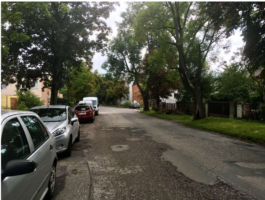
Obrázek 10 – Pohled na jižní část ul. Na Dražkách ze střední části ulice
