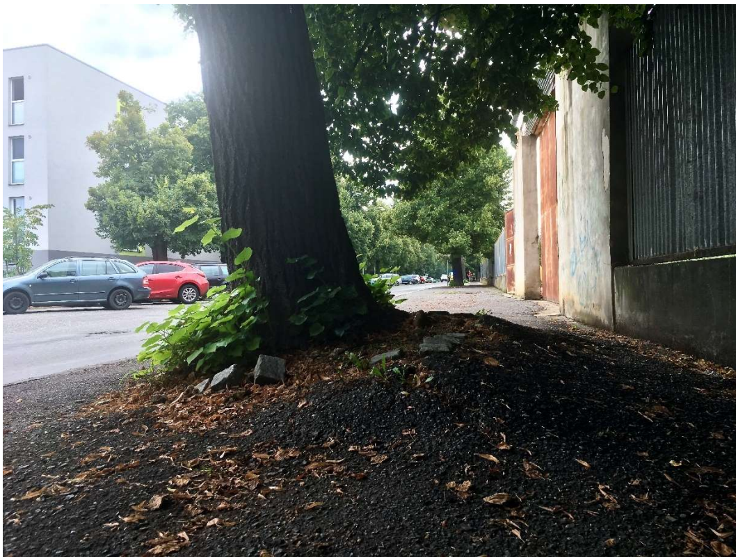
Obrázek 24 – Porucha chodníku v ul. U Archivu
