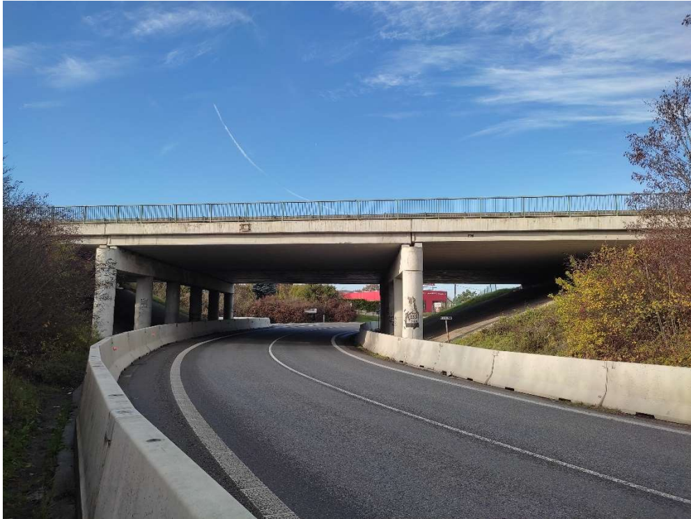
Obrázek 1: Začátek úseku – MÚK Bezděčín, sjezd z dálnice D10 (směr Turnov) na Bezděčín
