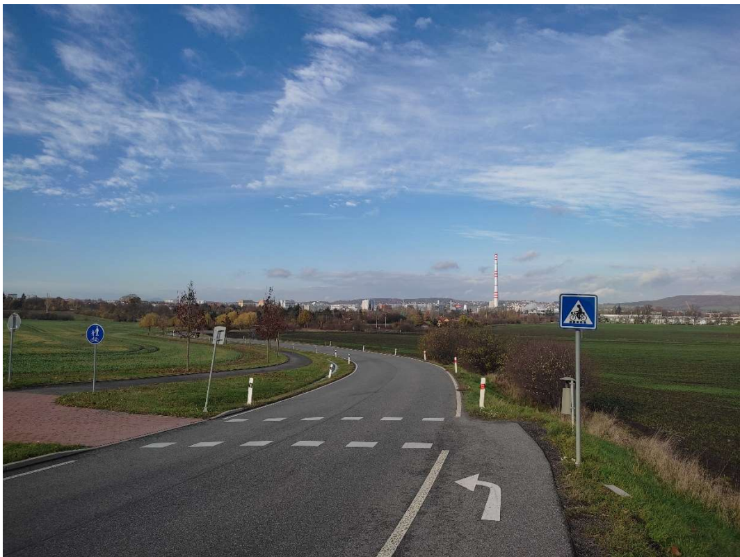
Obrázek 6: Silnice III/27513, Pohled na výhledový koridor silnice II/610 a žel. trati, které bude nutné přemostit, Jemníky
