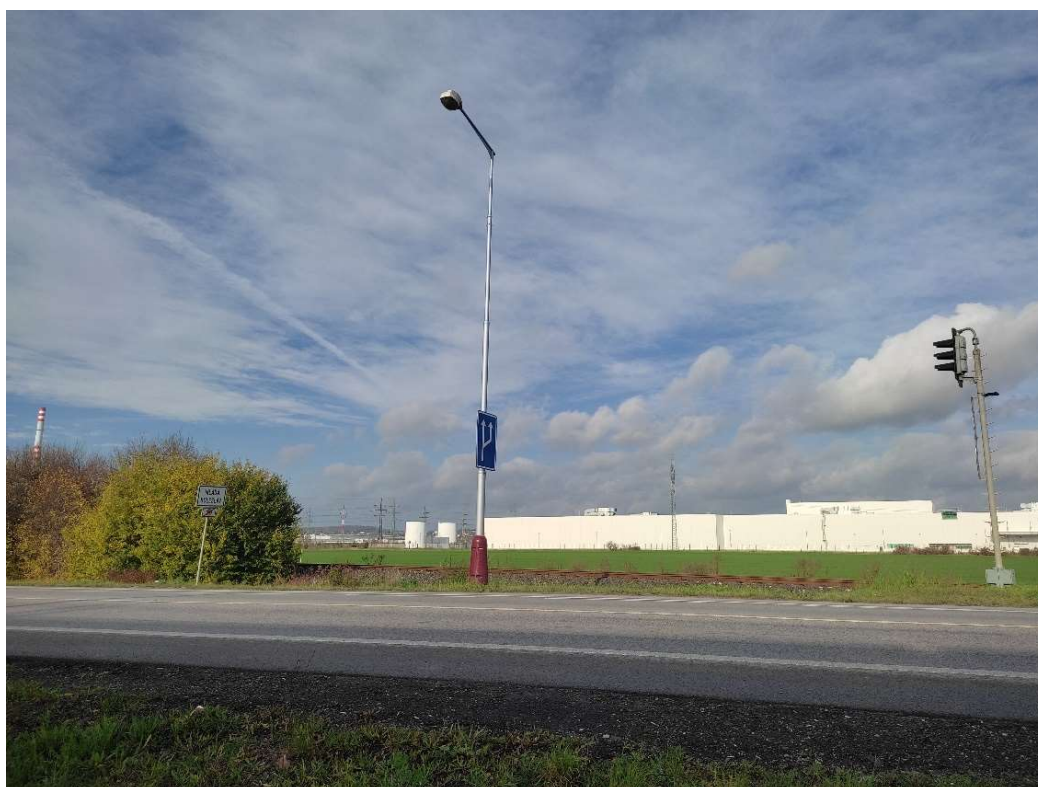
Obrázek 12: Pohled přes silnici I/16 a trať 64 na koridor pro trasu varianty 2 u PZ Škoda AUTO
