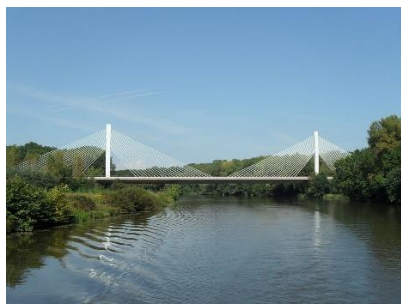
Obrázek 23 - Dálniční most přes Labe u Poděbrad [18]
