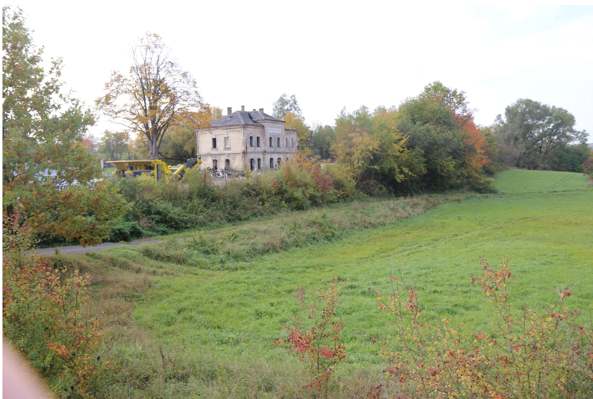
Foto č. 14 – Pohled na místo vzniku nové průsečné křižovatky
