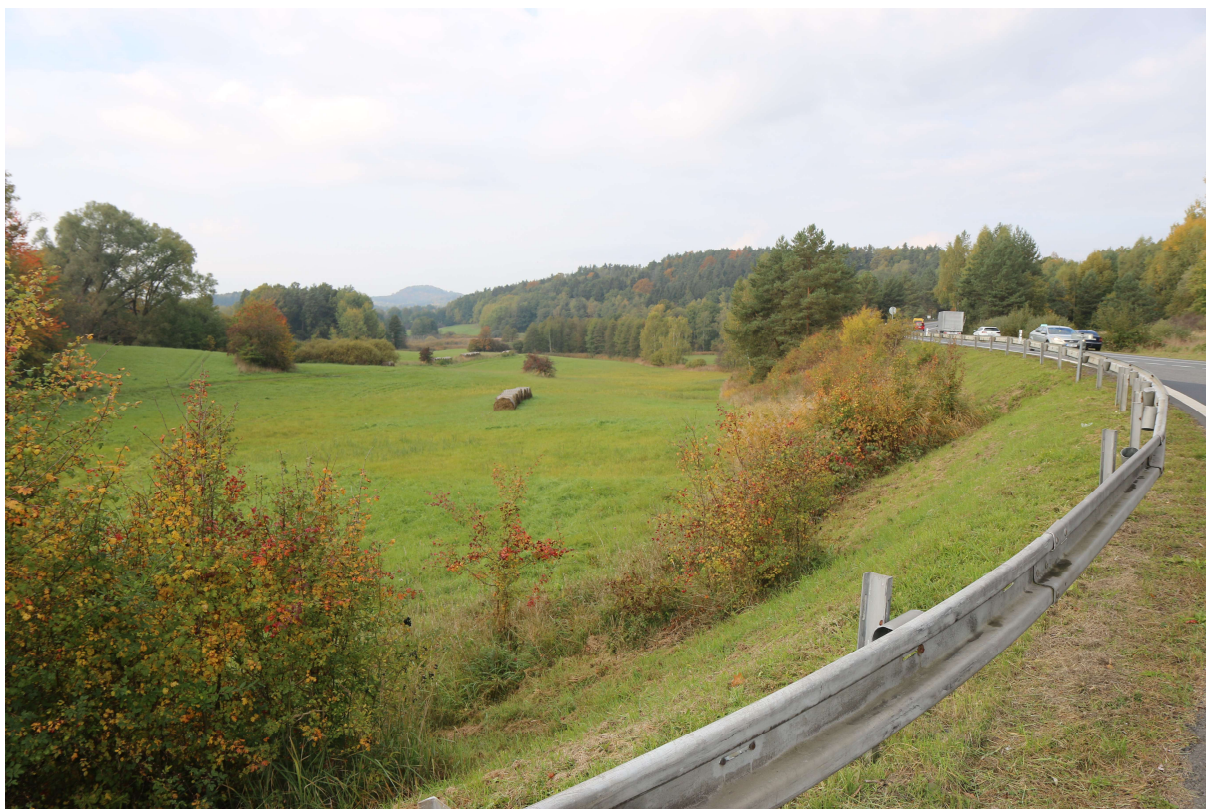
Foto č. 13 – Pohled na vysoký násyp přeložky stávající silnice I/13 k nové průsečné křižovatce
