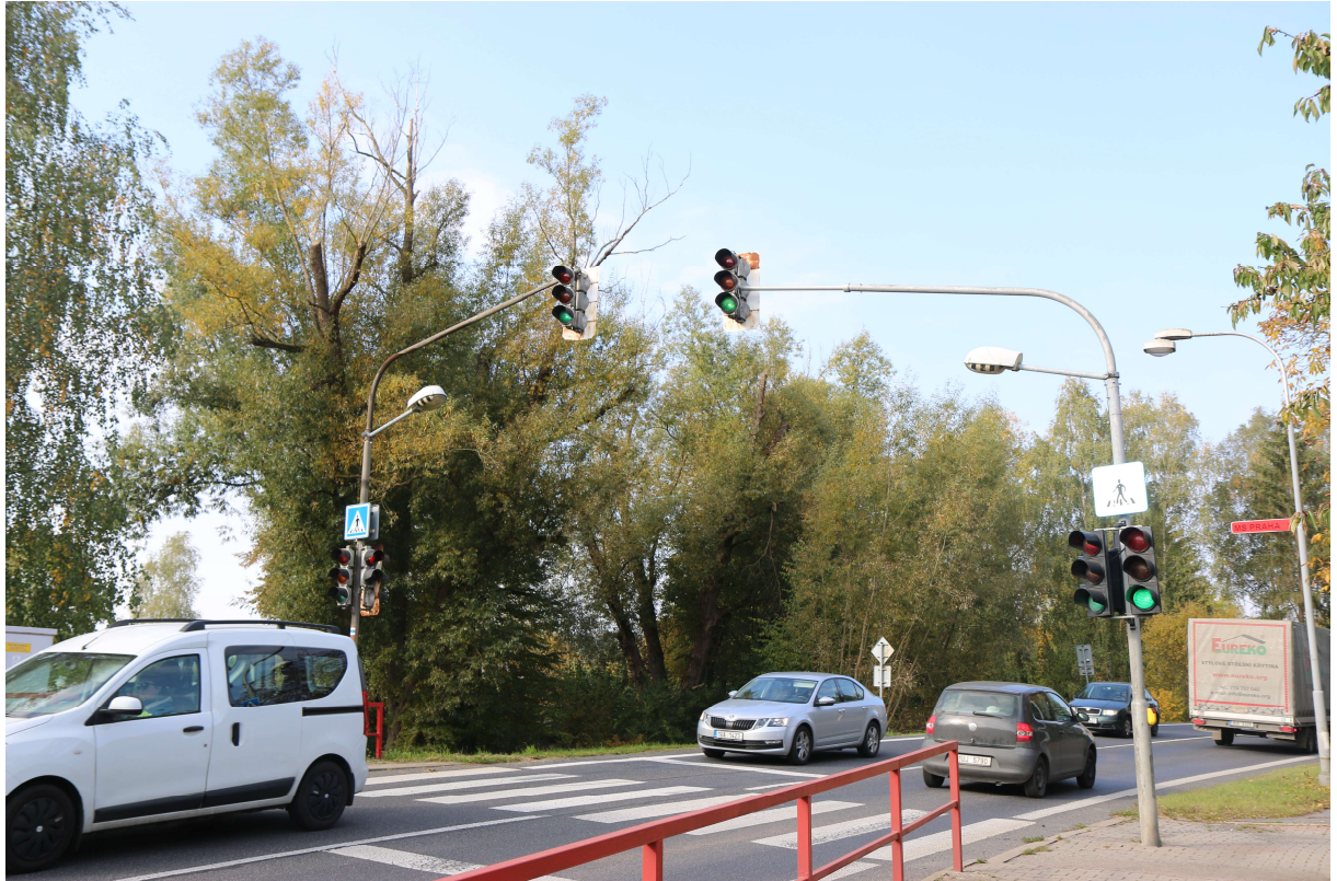
Foto č. 1 – Světelné semaforly na stávající komunikaci
