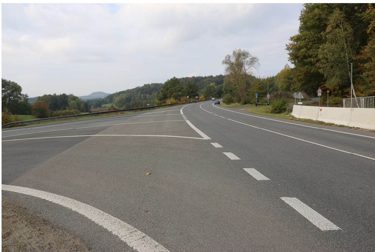
Foto č. 12 – Stávající napojení stykovou křižovatkou na konci úseku
