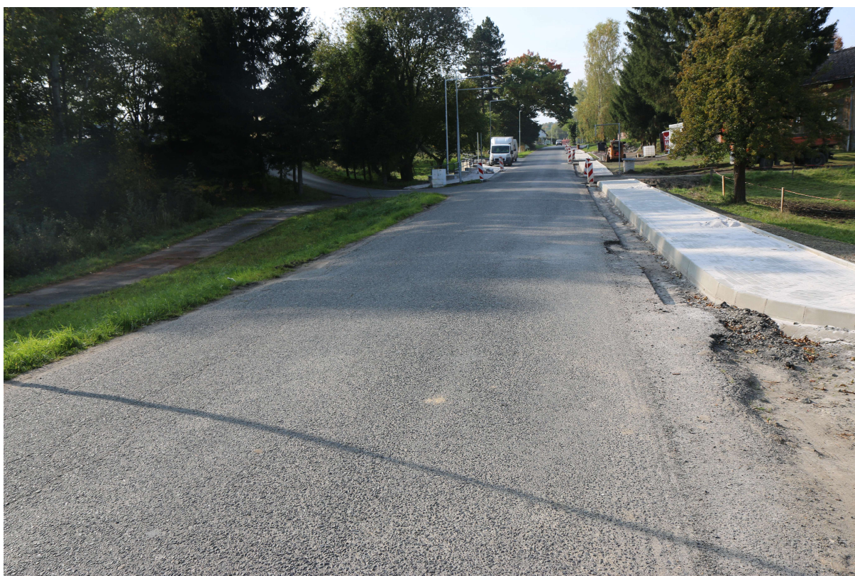
Foto č. 8 – Místo průsečné křižovatky se silnicí III/26846
