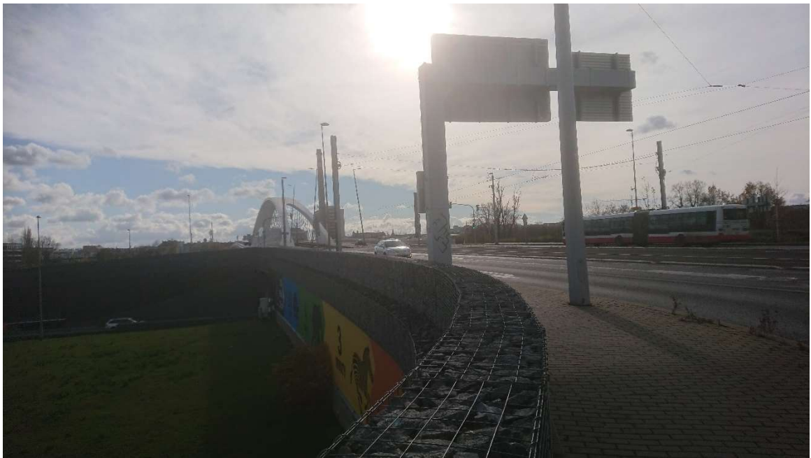
Fotografie 1: Severní předpolí Trojského mostu, pohled směrem do centra
