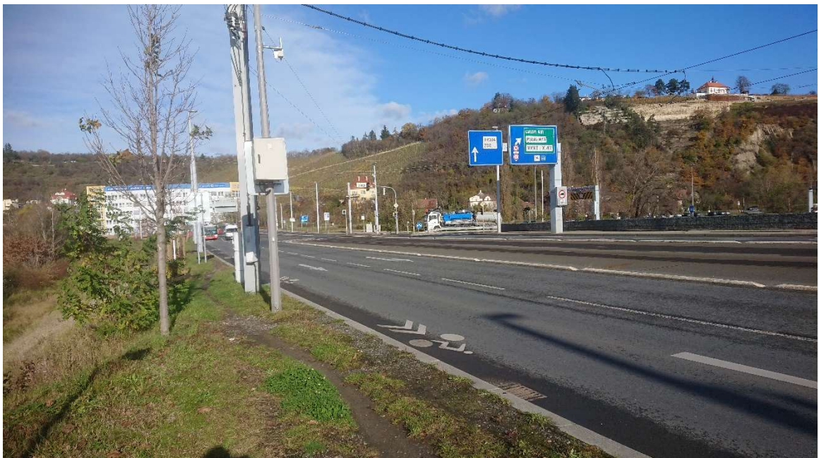
Fotografie 2: Mimoúrovňová křižovatka Pelc-Tyrolka spojující městský okruh s ulicí Pod Lisem. Pohled směrem z centra
