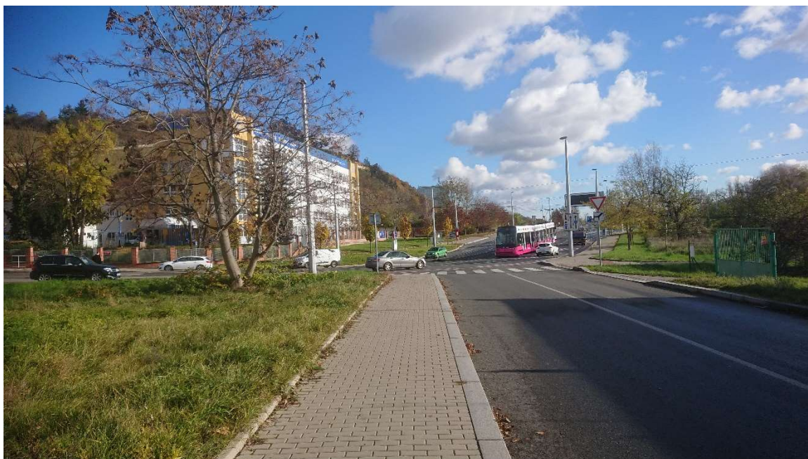
Fotografie 15: Pohled ze západní části ulice Povltavská směrem ke křižovatce s ulicí Pod Lisem. Za zelenými vraty v pravé části fotografie se nachází objekt tramvajové měnirny Trojská
