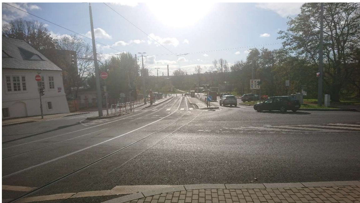
Fotografie 10: Křižovatka ulic Trojská a Pod Lisem, fotografováno z místa přechodu tramvajové trati ze samostatného na sdružené těleso (jízda proti směru staničení)
