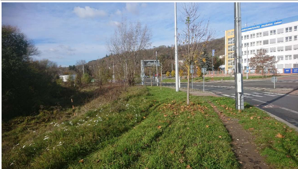
Fotografie 5: Pohled na úsek mezi křižovatkami ulic Povltavská s ulicí Pod Lisem. Jedná se o přeložku komunikace, která byla vybudována v roce 2014 za účelem napojení nového Trojského mostu. Celá přeložka se nachází v násypu.
