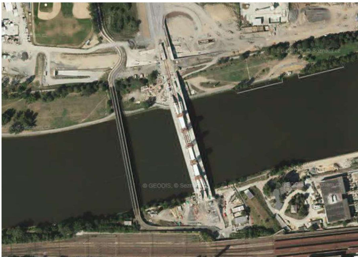
Obrázek 3: Letecký snímek z roku 2012. Vlevo starý Trojský most ("Rámusák"), vpravo výstavba nového Trojského mostu [33]
