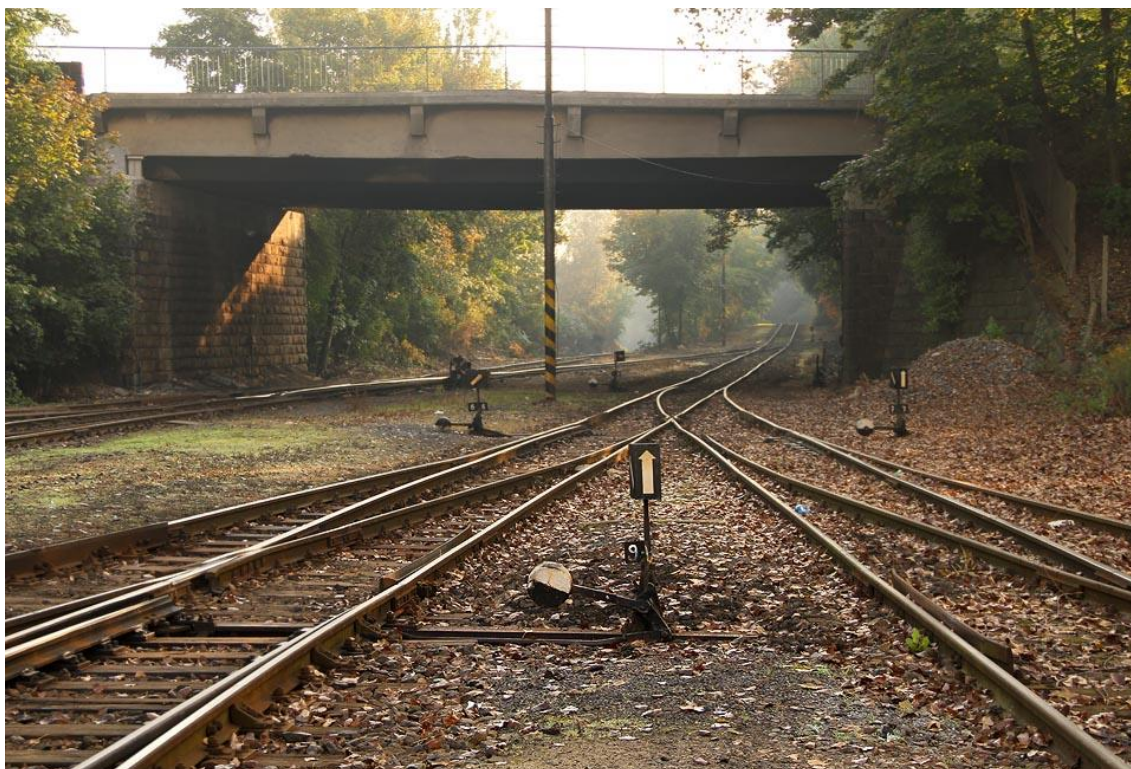
Obrázek 3: Pohled na most přes trať směrem od NNŽ na Malešice a vlečku (vpravo) 2014 [B]
