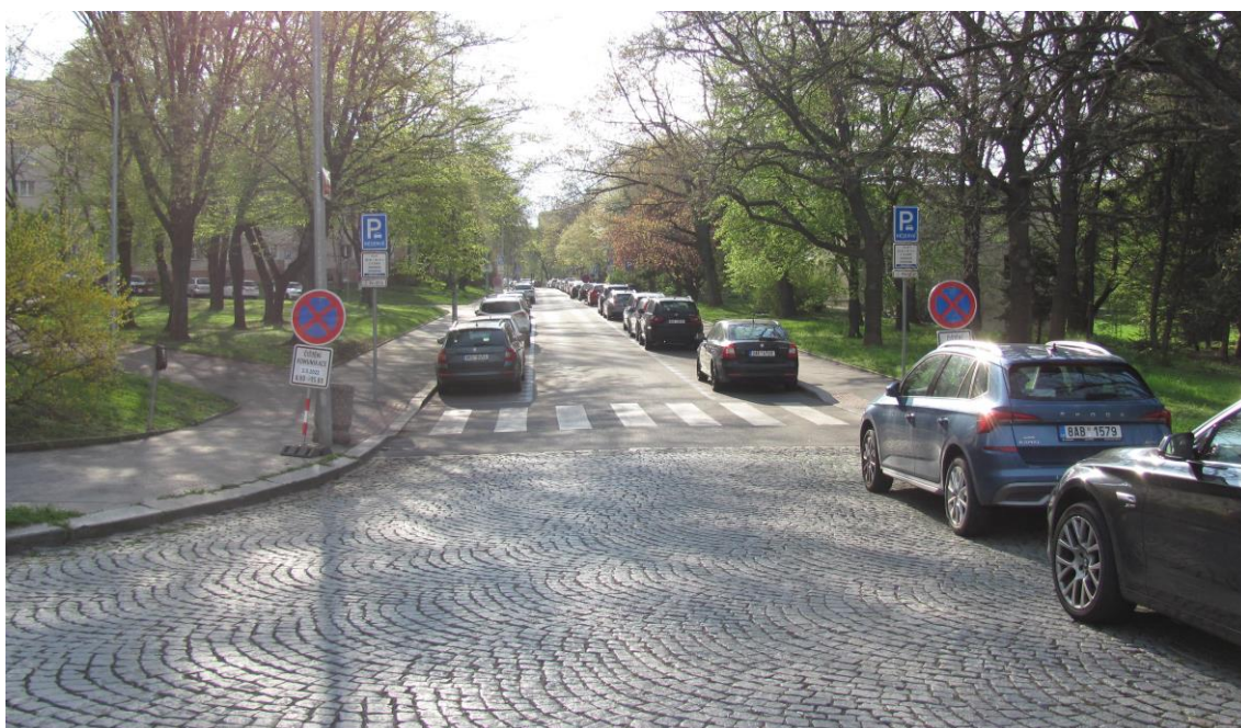
Foto 4.14 Pohled do ulice Na Okraji
