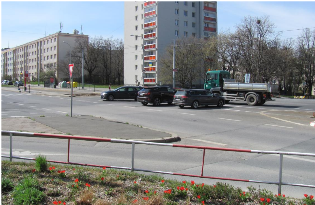
Foto 4.1 Pohled do křižovatky z jihovýchodu – původní
