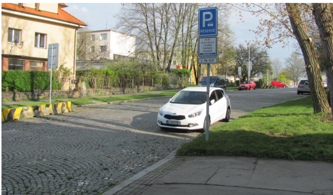
obr. 27 Pohled na ulici Na Větrníku do křižovatky Na Okraji směrem ke křižovatce Na Petřinách (od severu)
