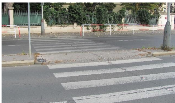
obr. 6 Pohled na přechod v ulici Jaselská
