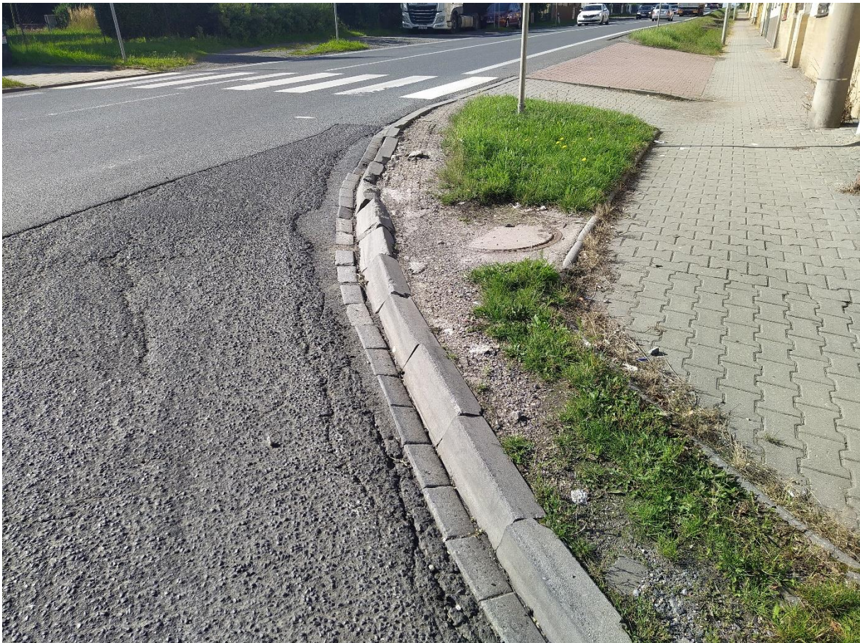
Obrázek 21 – Poničené obruby od odbočujících vozidel.
