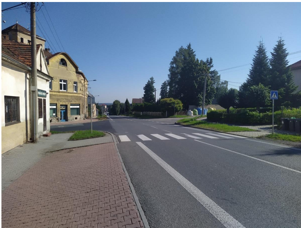
Obrázek 4 - Pohled ve směru jízdy do Plzně
