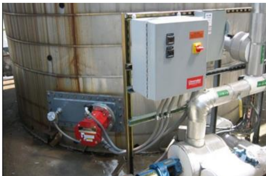
Obr. 15: Ponorný ohříváč vně nádrže včetně ovládacích prvků [14].
