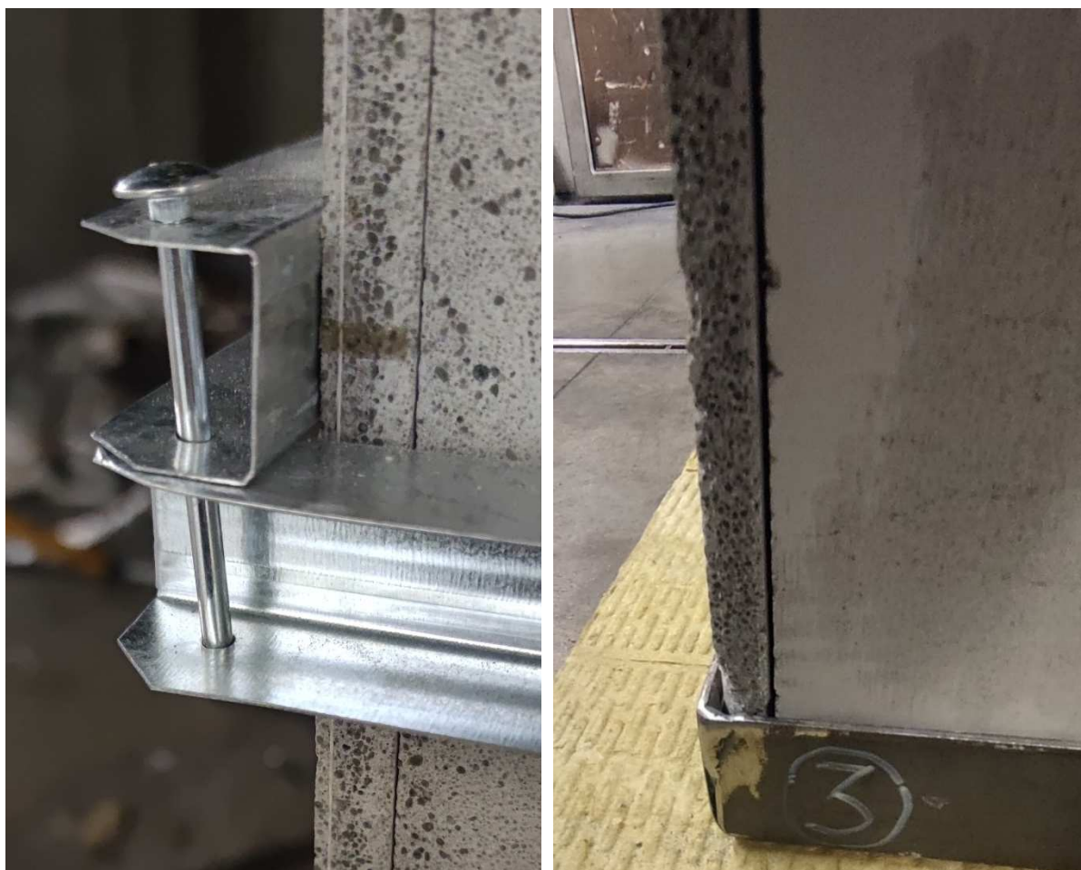
a) Detail spoje bočních stěn
