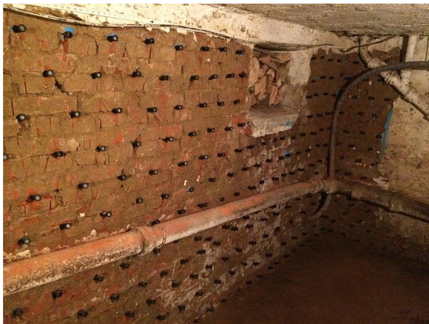
Obrázek 12 - Plošná injektáž 2 (Zdroj: https://sanacekonstrukci.cz/wp-content/uploads/2021/09/WhatsApp-Image-2021-08-24-at-20.03.03-2.jpeg )
