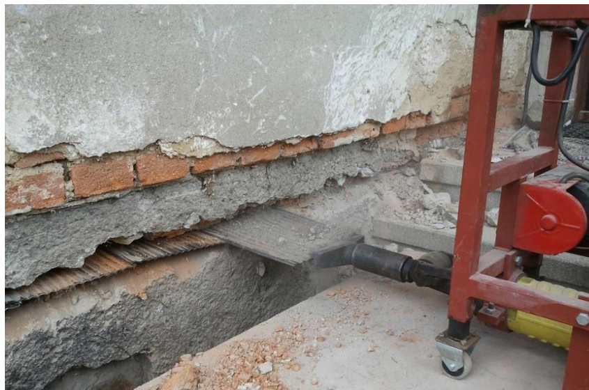
Obrázek 5 - Zarážení desek (Zdroj: https://www.estav.cz/img/ /3510.foto/ do-clanku-2013-05-24-09.23o.jpg?1468236282 )
