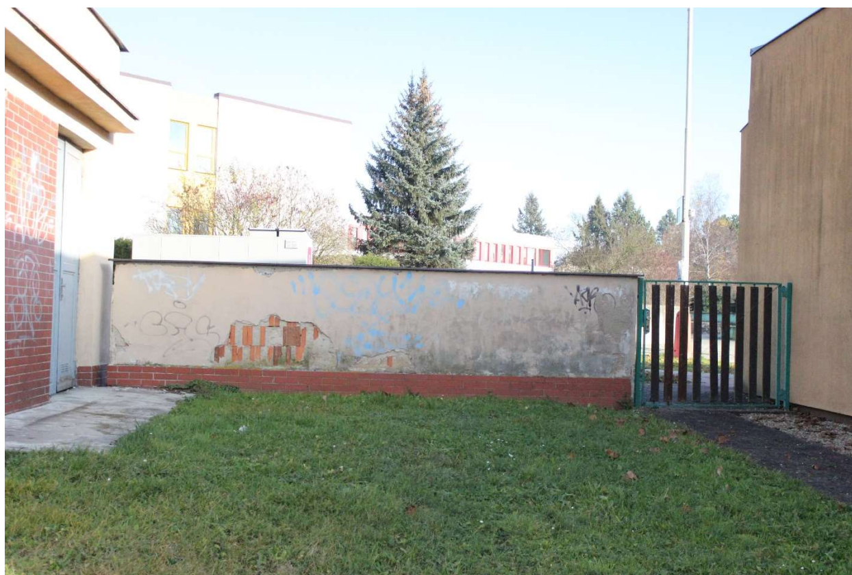
Obr. 21 - Bod 21 na mapě fotodokumentací pilotního povodí ve městě Tábor
