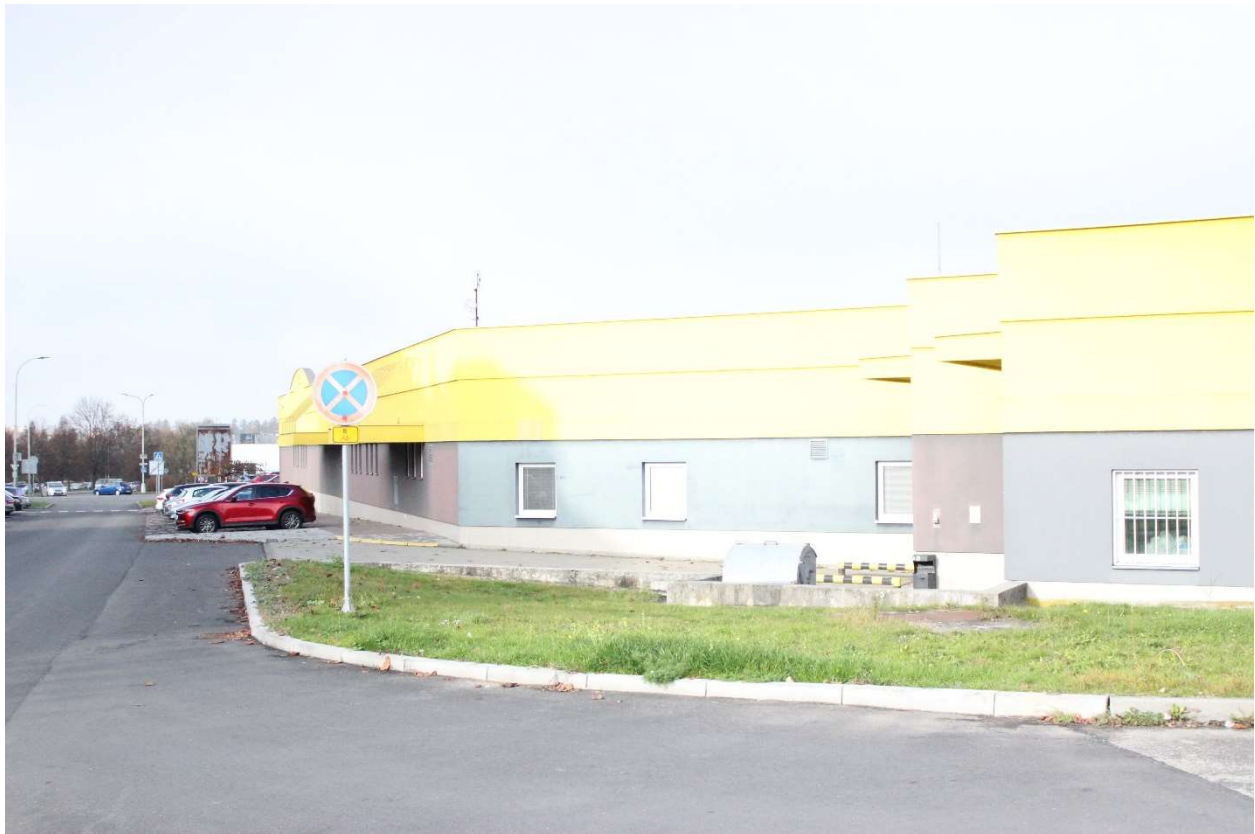
Obr. 10 - Bod 10 na mapě fotodokumentací pilotního povodí ve městě Tábor
