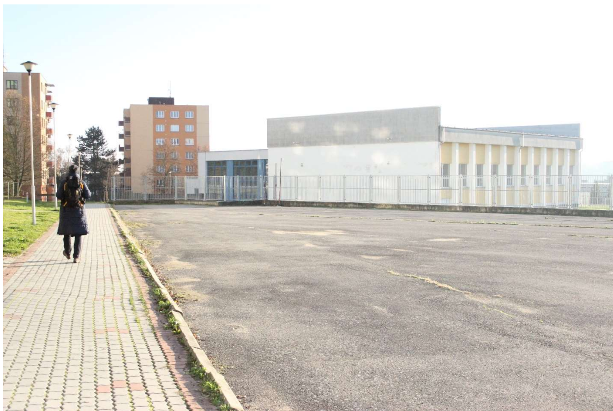
Obr. 41 - Bod 41 na mapě fotodokumentací pilotního povodí ve městě Tábor
