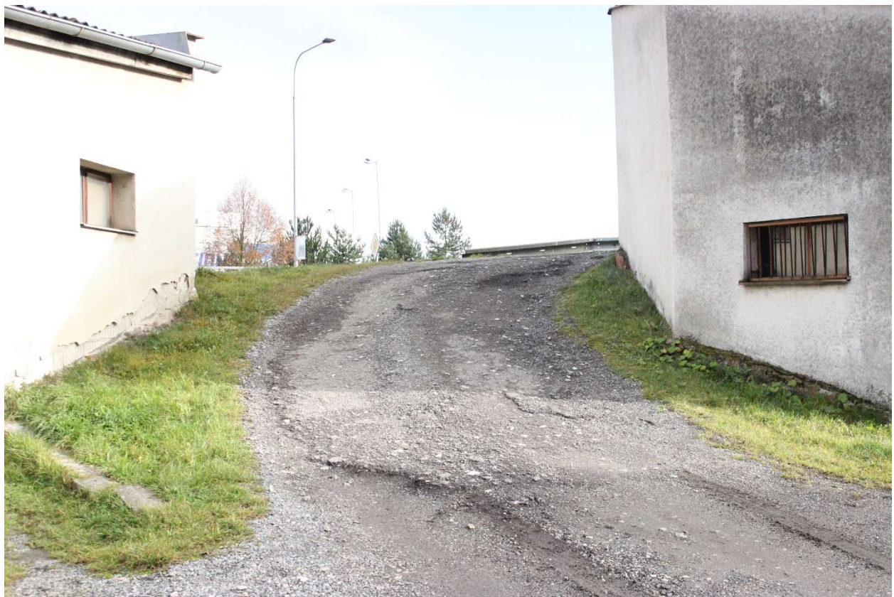
Obr. 6 - Bod 6 na mapě fotodokumentací pilotního povodí ve městě Tábor
