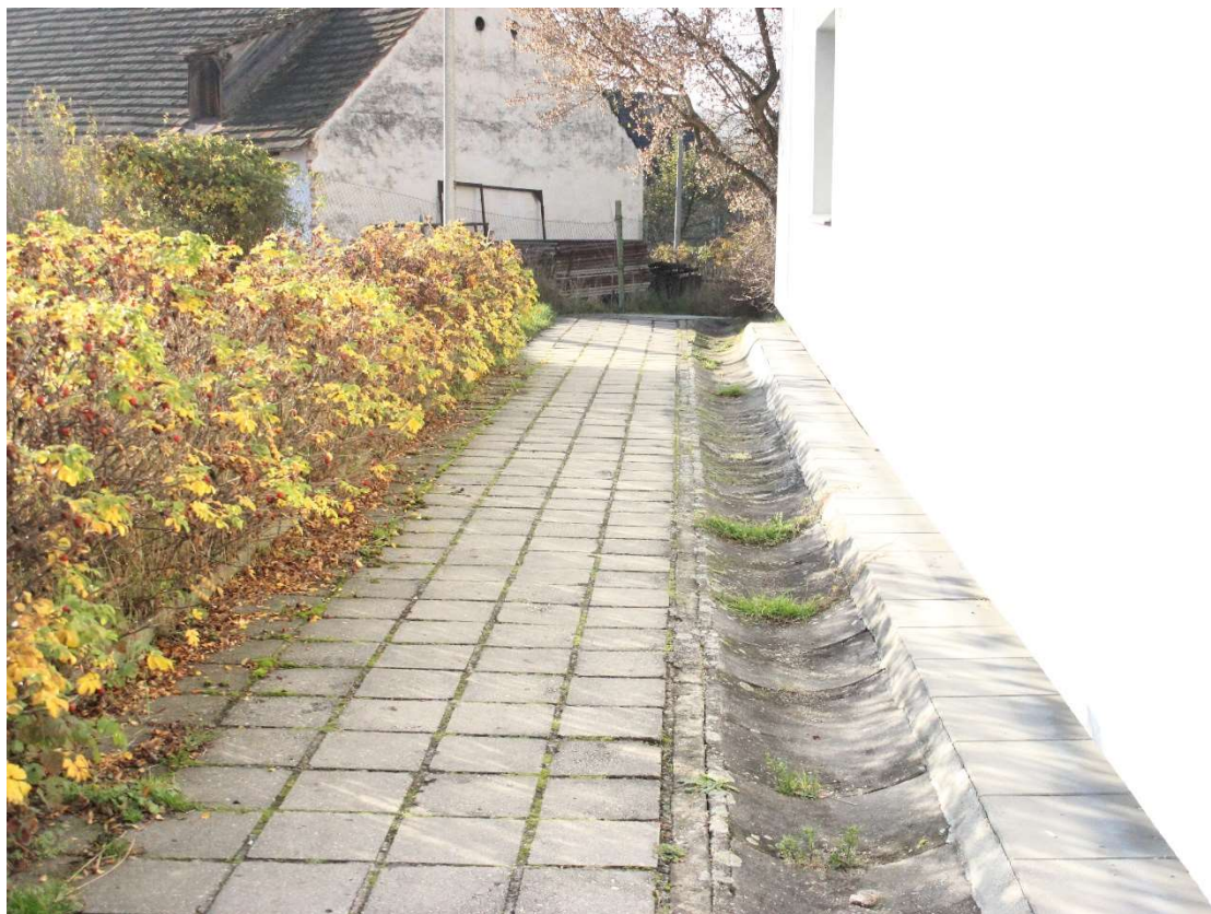
Obr. 24 - Bod 24 na mapě fotodokumentací pilotního povodí ve městě Tábor
