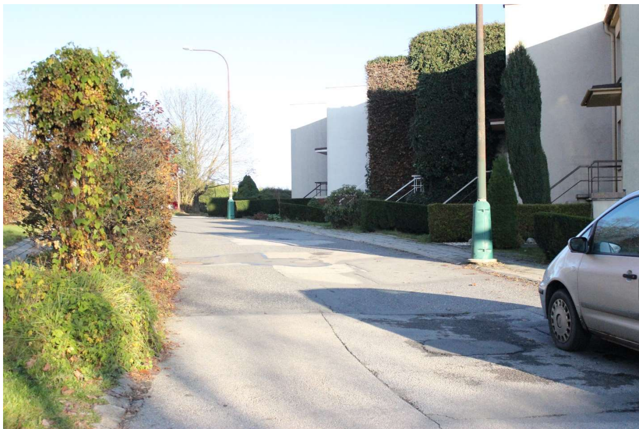
Obr. 33 - Bod 33 na mapě fotodokumentací pilotního povodí ve městě Tábor
