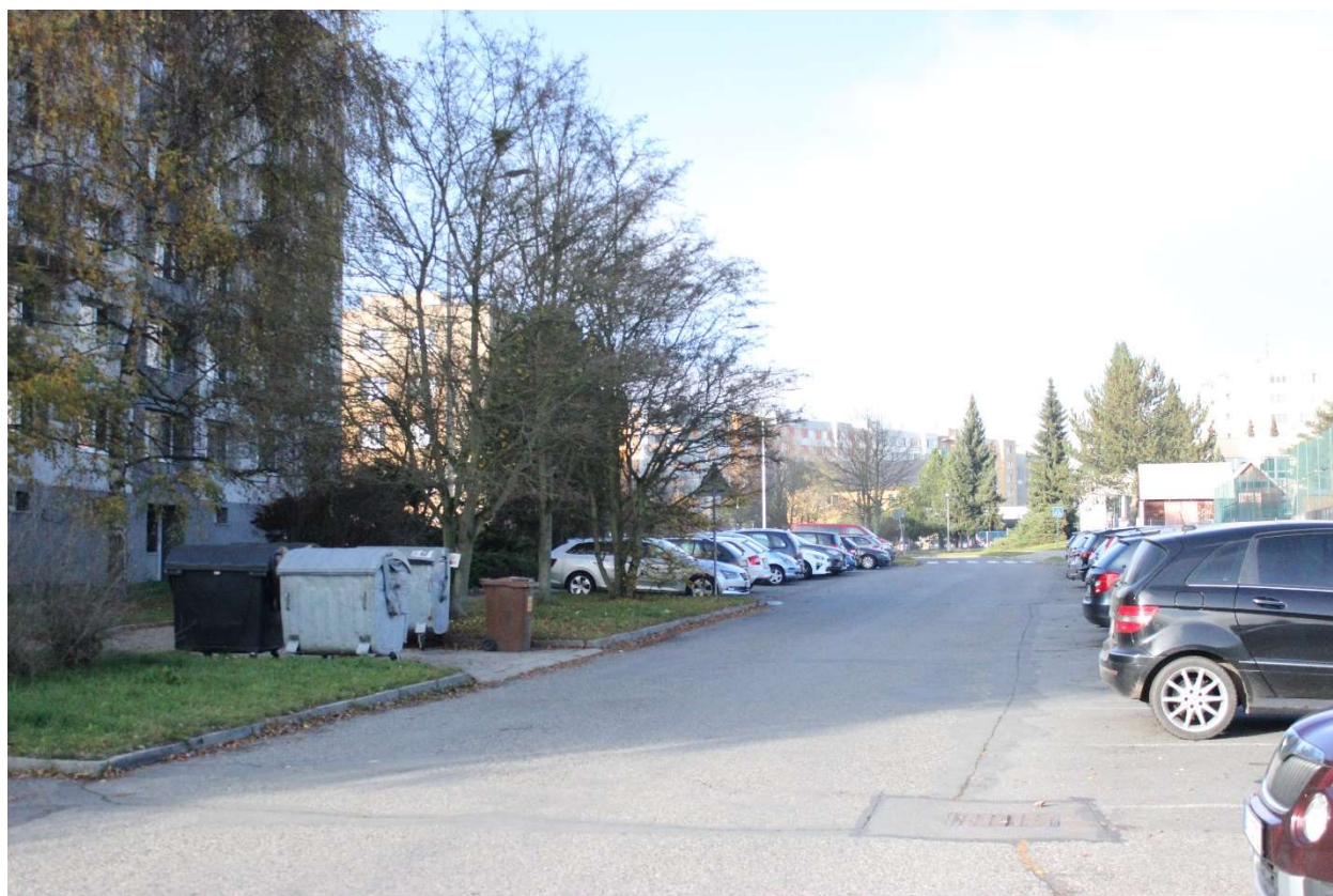
Obr. 19 - Bod 19 na mapě fotodokumentací pilotního povodí ve městě Tábor
