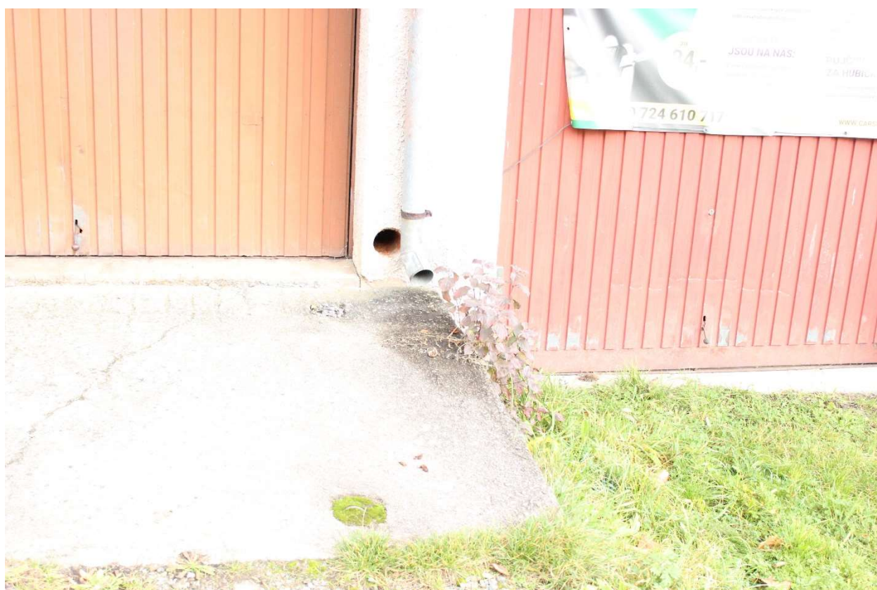
Obr. 1 – Bod 1 na mapě fotodokumentací pilotního povodí ve městě Tábor
