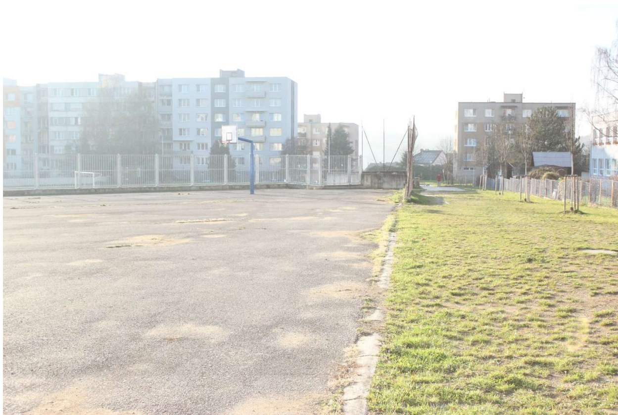
Obr. 40 - Bod 40 na mapě fotodokumentací pilotního povodí ve městě Tábor
