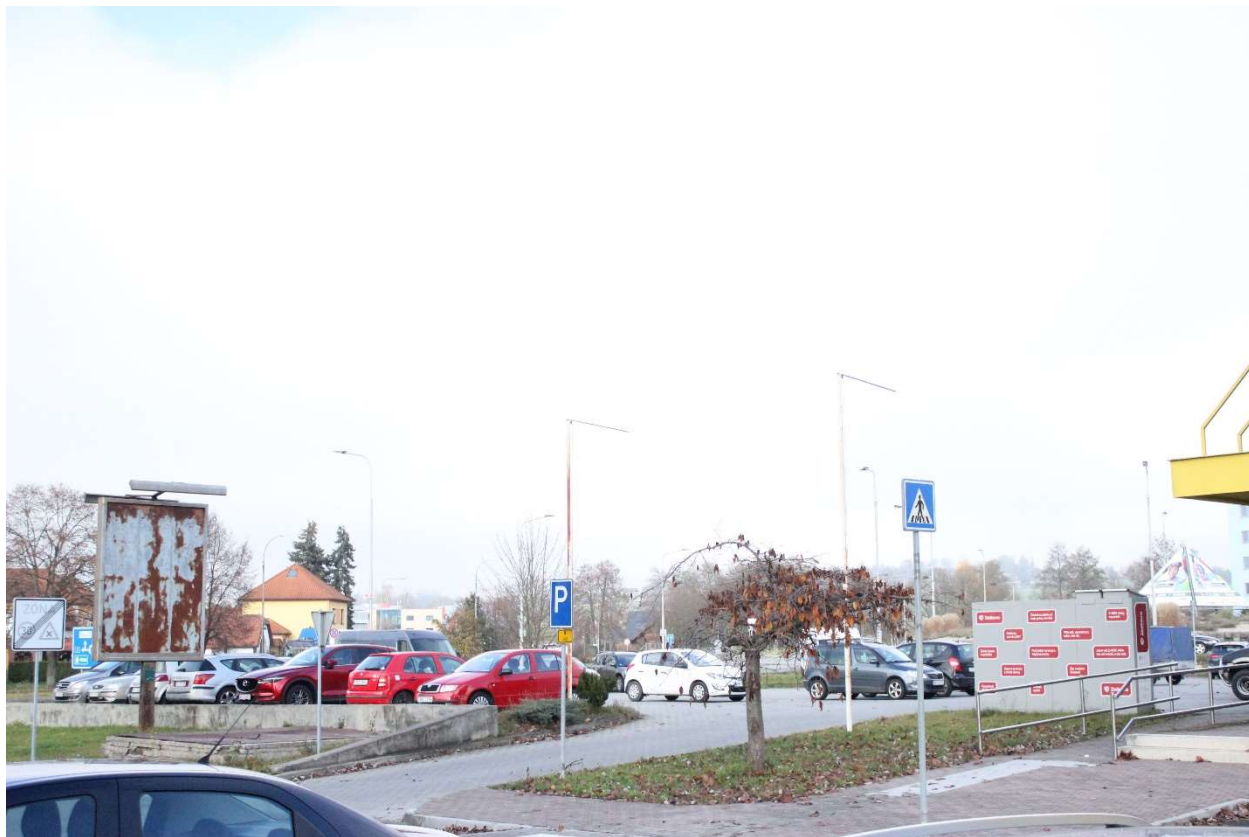
Obr. 12 - Bod 12 na mapě fotodokumentací pilotního povodí ve městě Tábor
