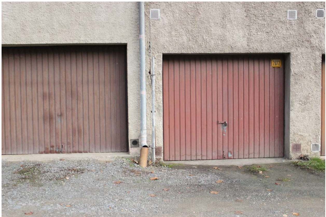
Obr. 5 - Bod 5 na mapě fotodokumentací pilotního povodí ve městě Tábor
