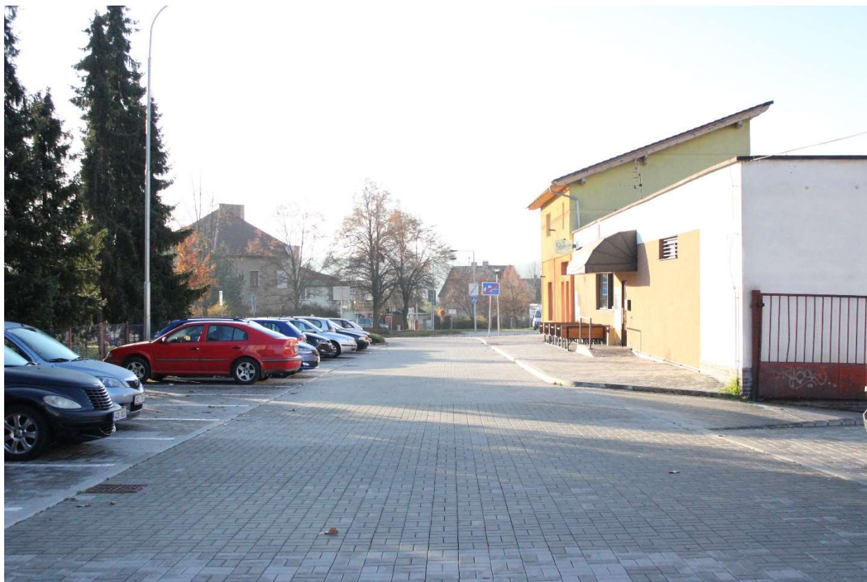
Obr. 43 - Bod 43 na mapě fotodokumentací pilotního povodí ve městě Tábor
