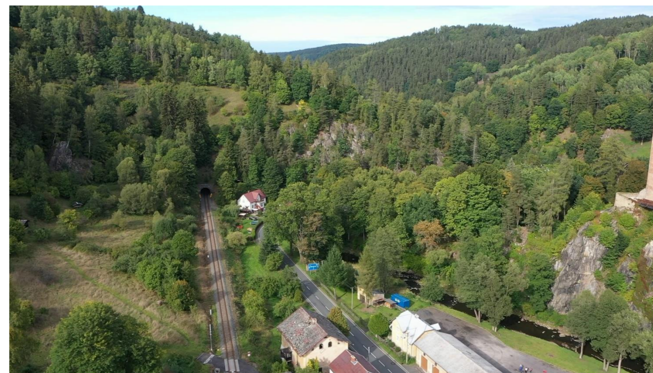
Obrázek CV – železniční trať s tunelem
