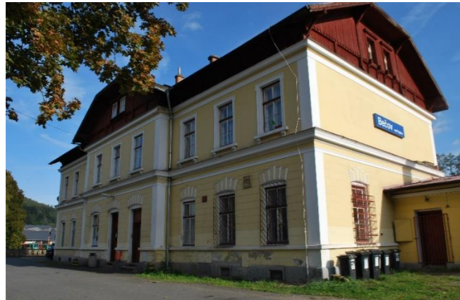
Obrázek XLVIII – výpravní budova železniční stanice
