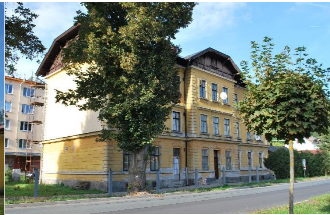
Obrázek XLIX – obytná budova železniční stanice
