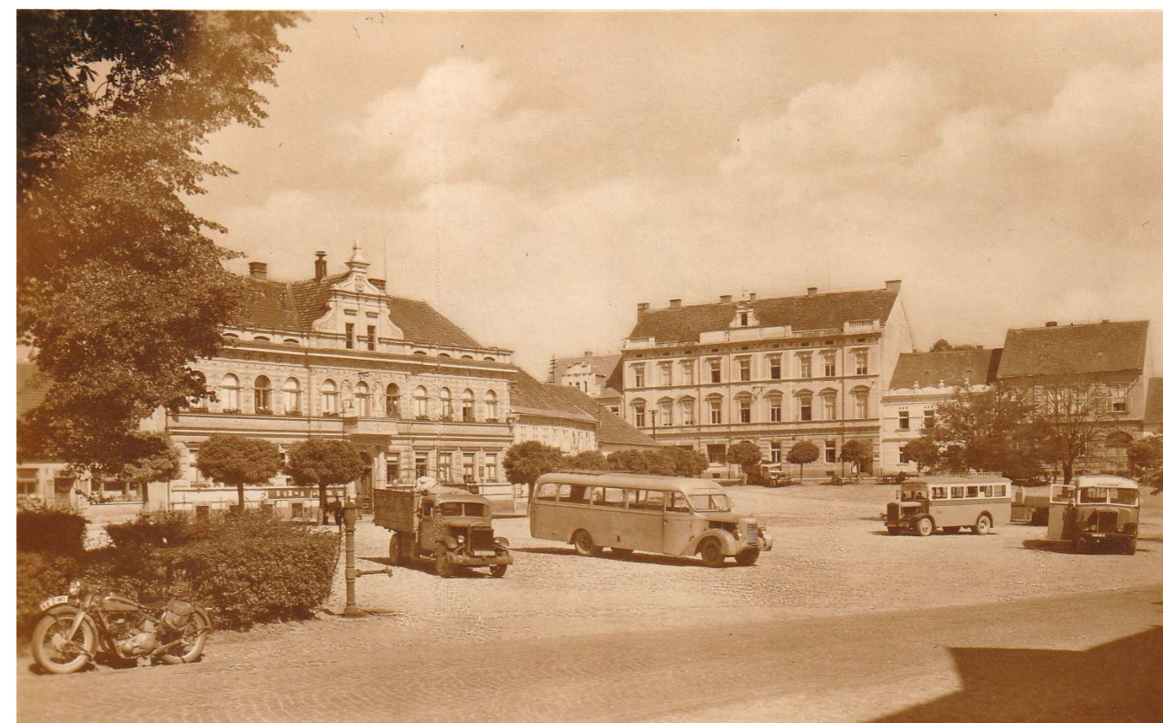
Obrázek 34: Centrum Milevska v roce 1948 (Šindelář, 2022)
