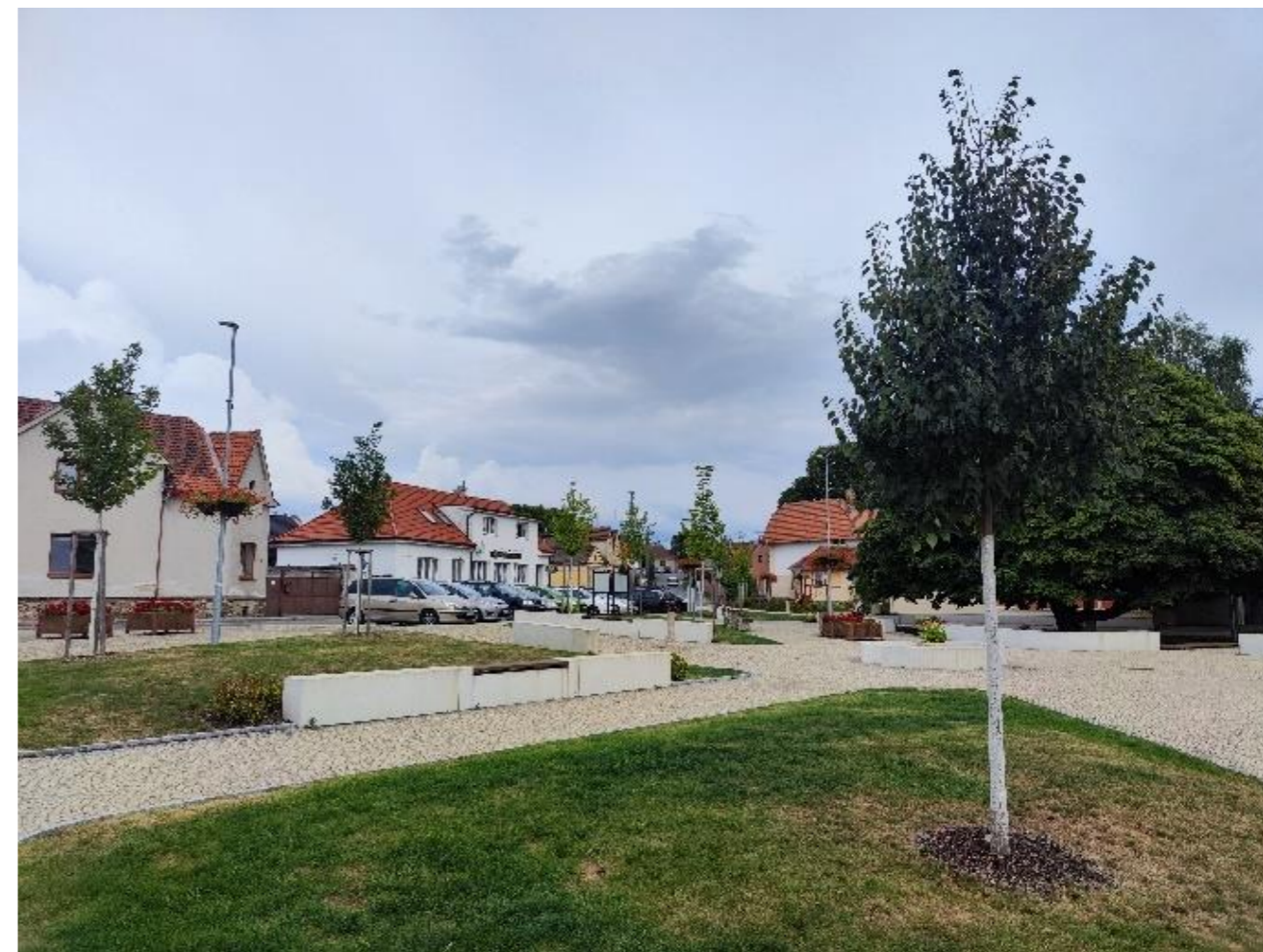
Obrázek 22: Zrekonstruovaná náves v Sepekově (Řezáč, 2022)
