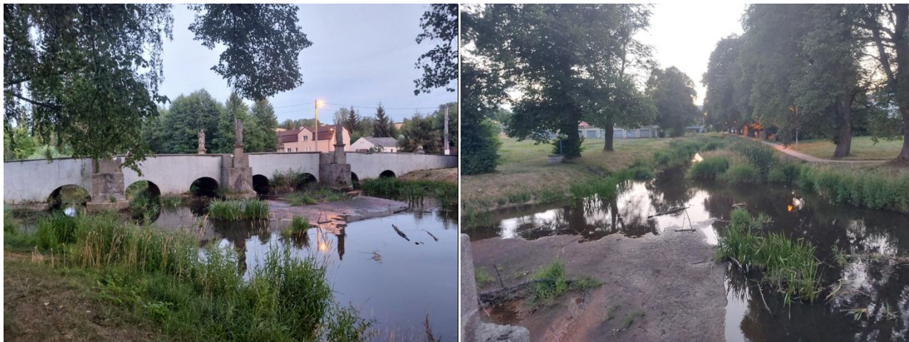
Obrázek 24: Koryto Radbuzy ve městě Bělá. (foto autor)
