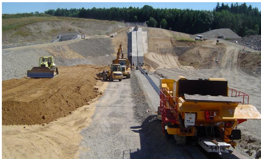
Obrázek 27: Realizace asfaltobetonového těsnícího jádra. [zdroj: allcons.de] [44]
