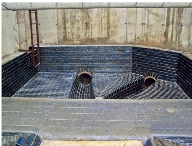
Obrázek 12 Příklad odlehčovací komory [5]
