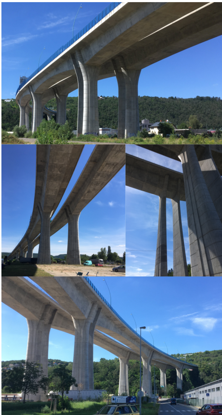
Obrázek 2: Most přes údolí Beronky na dálnici D0, úsek SOKP 514, stavba SO 204/1.4
