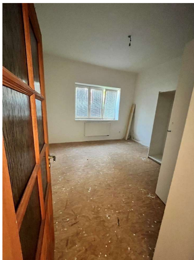
Obrázek 16: Fotografie stávajícího stavu – pokoj INP
