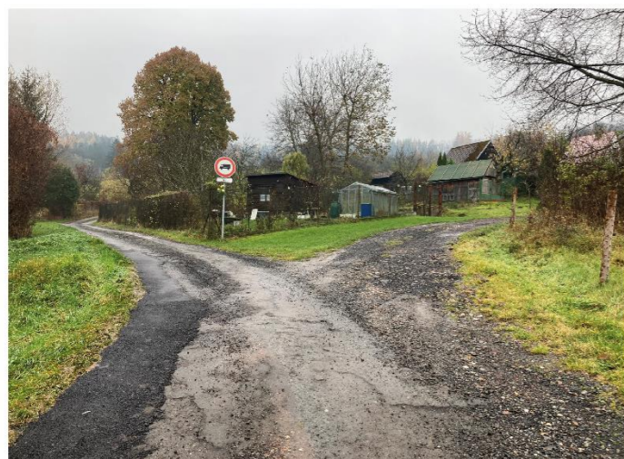
Obr 1.48 Vstup do osady
