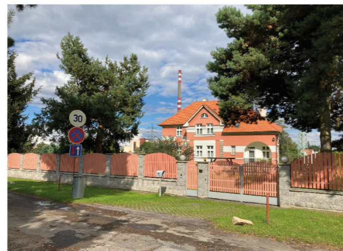
Obr 1.33 Narušení stavbami rodinných domů
