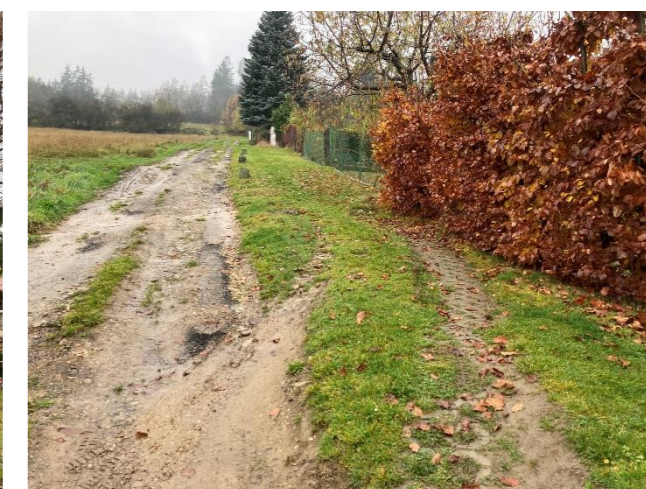
Obr 6 Eroze přístupových cest
