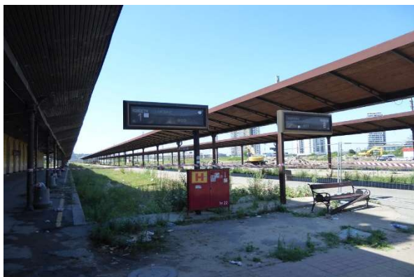
Obrázek 7 - bývalé Hlavní Nádraží, stav v roce 2021
