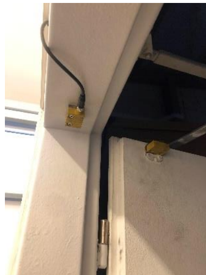
Obrázek 12.3 Bezpečnostní pojistka ve dveřích
