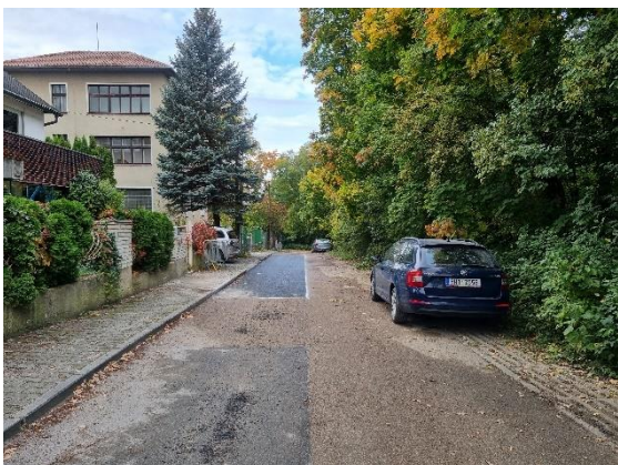
Obr. 46: Nedostatečný průjezdný profil (Stání vozidel) 63
