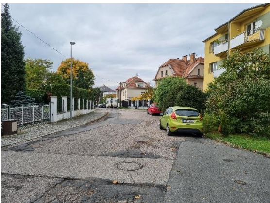
Obr. 41: Nedostatečný průjezdný profil (Stání vozidel) 55
