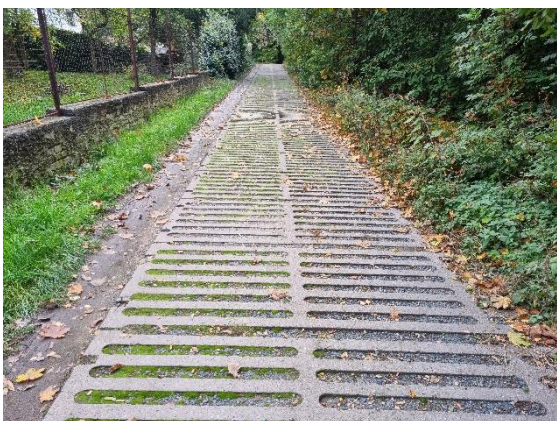
Obr. 45: Nevyhovující povrch komunikace, Chybějící prostor pro pěší, Nedostatečný průjezdný profil (šířka komunikace) 61
