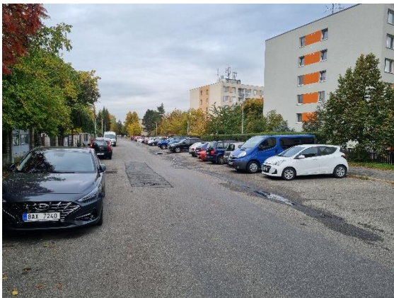
Obr. 31: Chybějící vodorovné dopravní značení 39
