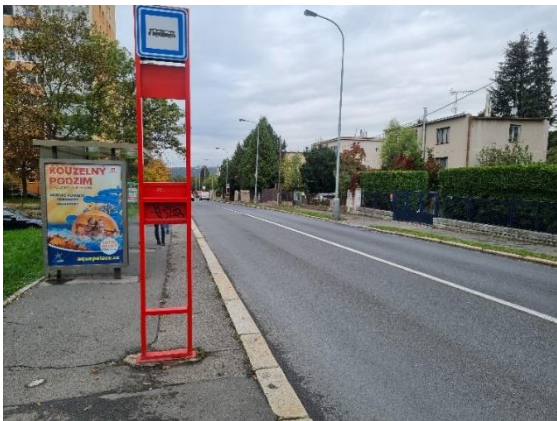
Obr. 64: Chybějící vodorovné značení (V11a) 88
