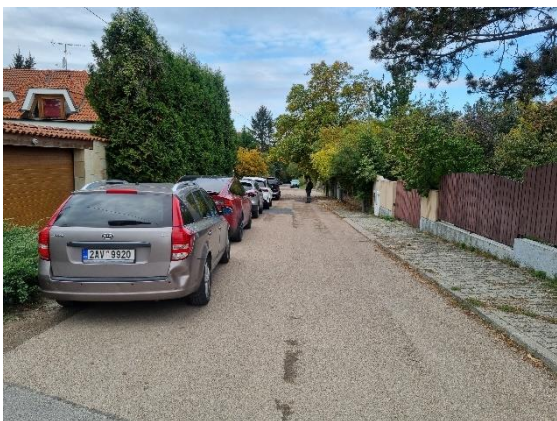
Obr. 44: Nedostatečný průjezdný profil (Stání vozidel) 59
