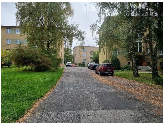
Obr. 38: Nedostatečný průjezdný profil (Stání vozidel) 50
