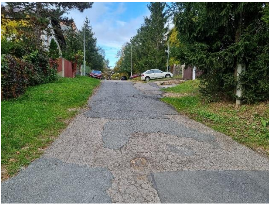
Obr. 58: Nedostatečný průjezdný profil (šířka komunikace), Chybějící prostor pro pěší 81
