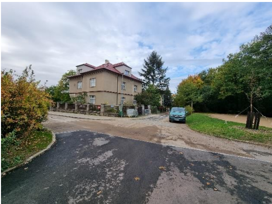
Obr. 16: Chybějící přechod pro chodce nebo místo pro přecházení 21
