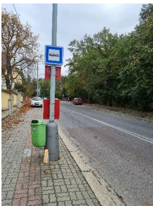
Obr. 57: Chybějící vodorovné značení 79
