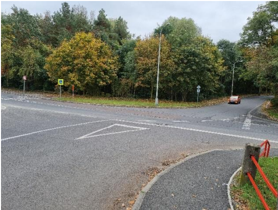
Obr. 19: Příliš rozlehlá křižovatka, Chybějící přechod pro chodce nebo místo pro přecházení 24
