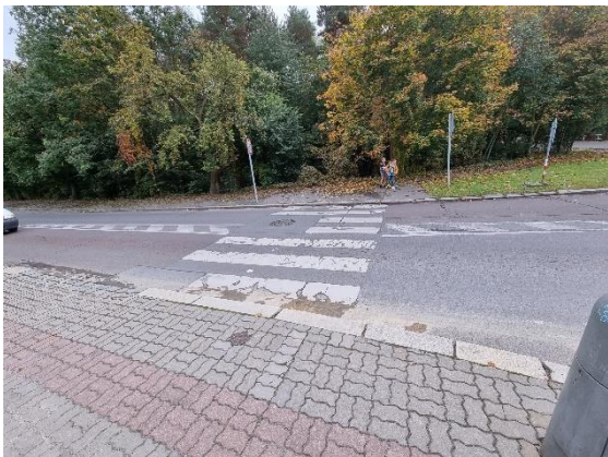
Obr. 20: Chybějící vodorovné značení pro OSSPO 25
