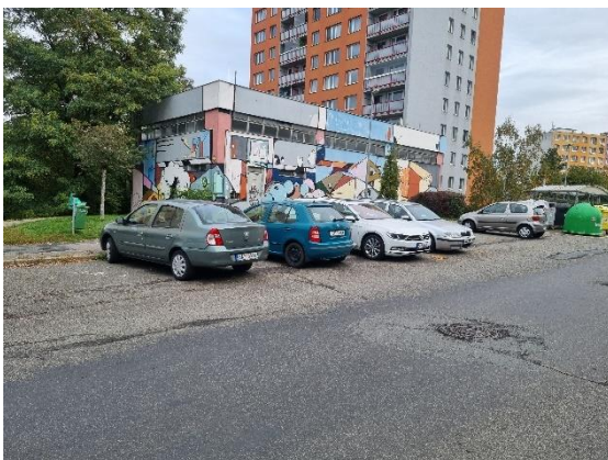
Obr. 29: Chybějící vodorovné značení 36
