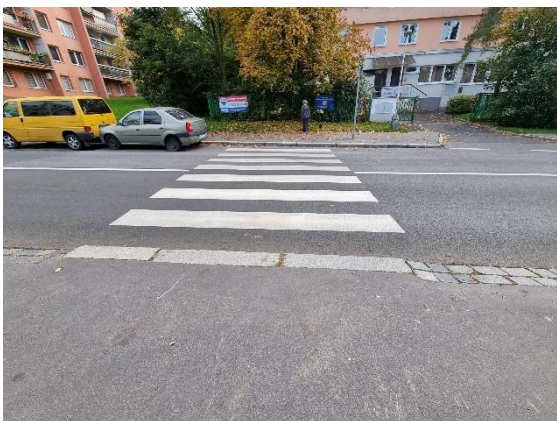
Obr. 65: Chybějící vodorovné značení pro OSSPO 89
