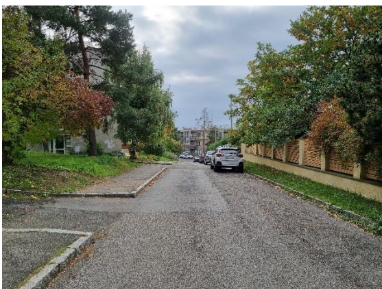
Obr. 55: Nedostatečný průjezdný profil (Stání vozidel) 77
