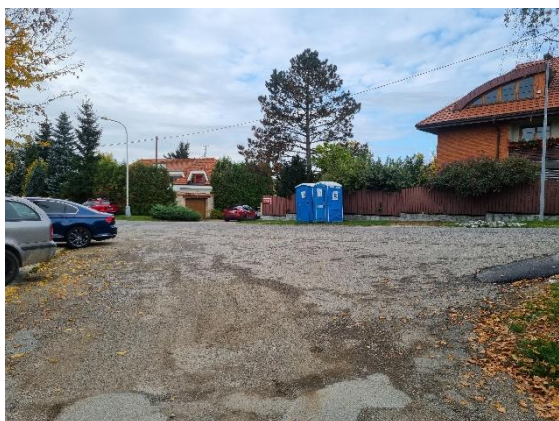
Obr. 13: Chybějící vodorovné značení 18
