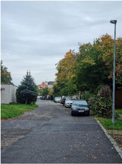
Obr. 34: Nedostatečný průjezdný profil (Stání vozidel) 44
