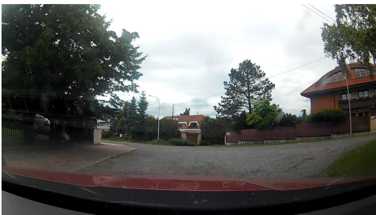
Obr. 12: Příliš rozlehlá křižovatka, Chybějící přechod pro chodce nebo místo pro přecházení 17
