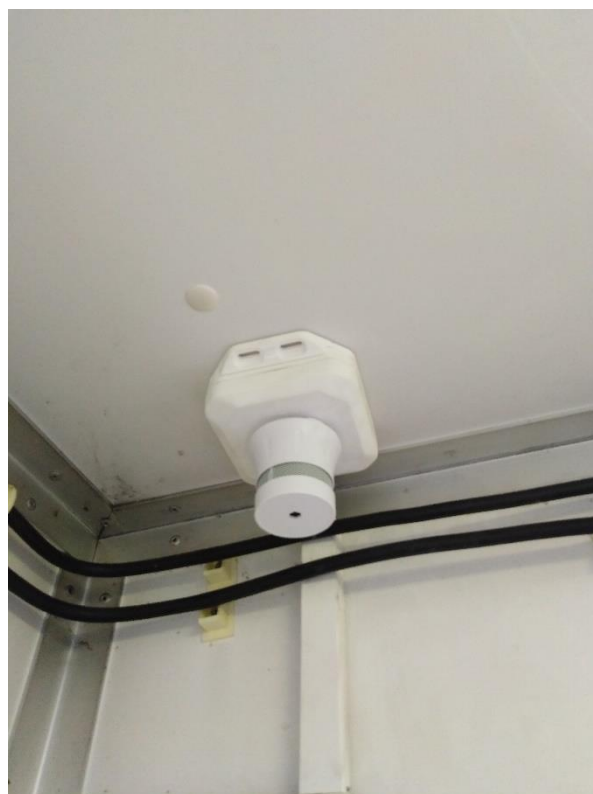
Obrázek 15 a 16. Umístění jednotky s požárním čidlem [Firma Intesys]
