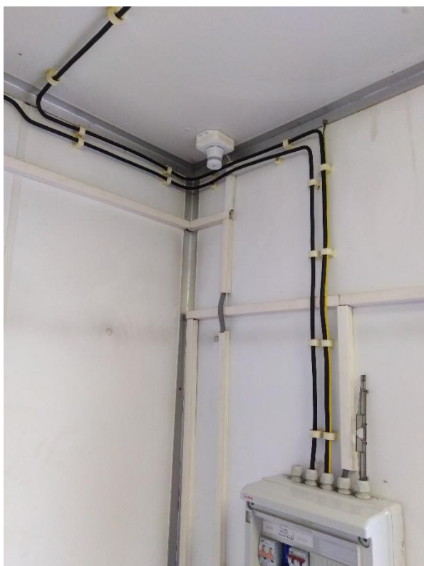
Obrázek 15 a 16. Umístění jednotky s požárním čidlem [Firma Intesys]
