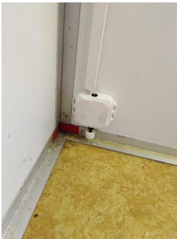
Obrázek 17. Umístění jednotky se záplavovým senzorem [Firma Intesys]
