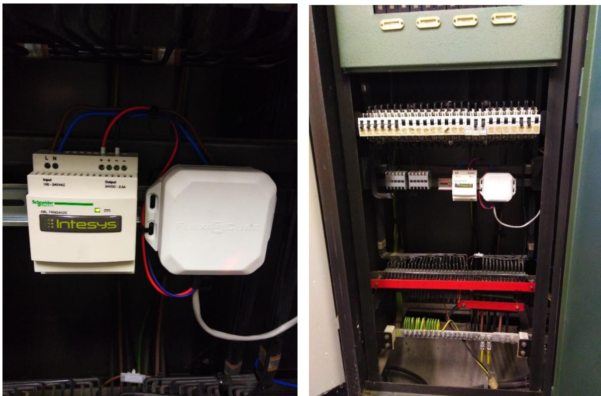
Obrázek 13 a 14. Umístění jednotky v elektroměru [Firma Intesys]
