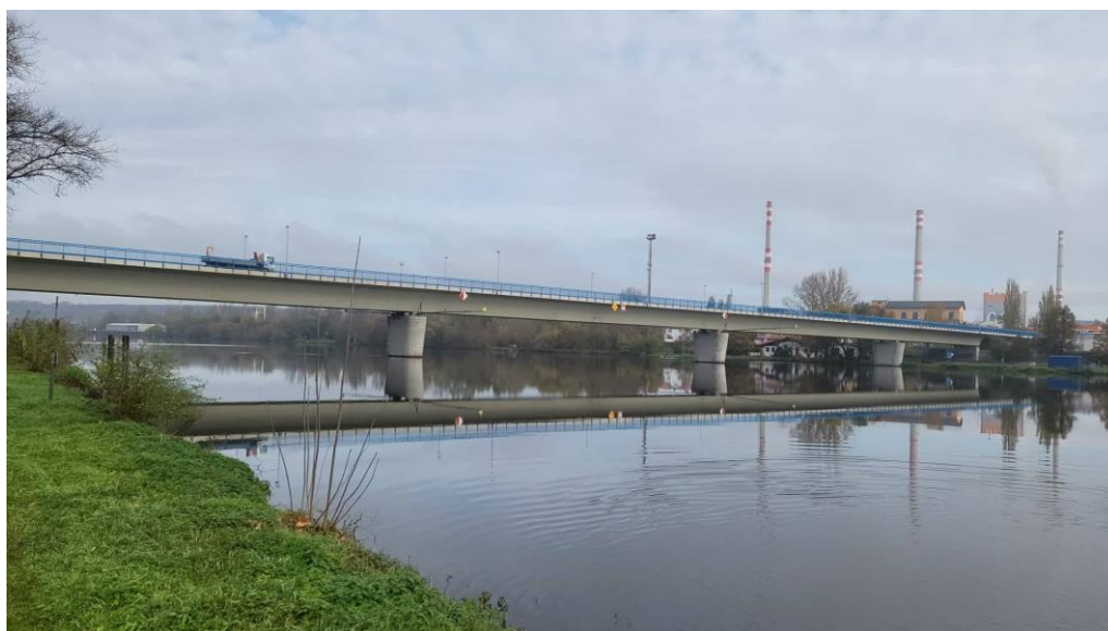
Obrázek 3 Pohled z levého břehu Labe na most spojující Hněvice a Štětí
