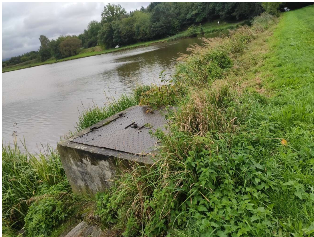
Obr. č. 2 - Uzavřený požerák, foto: Aneta Řeháková, 19.9.2022
