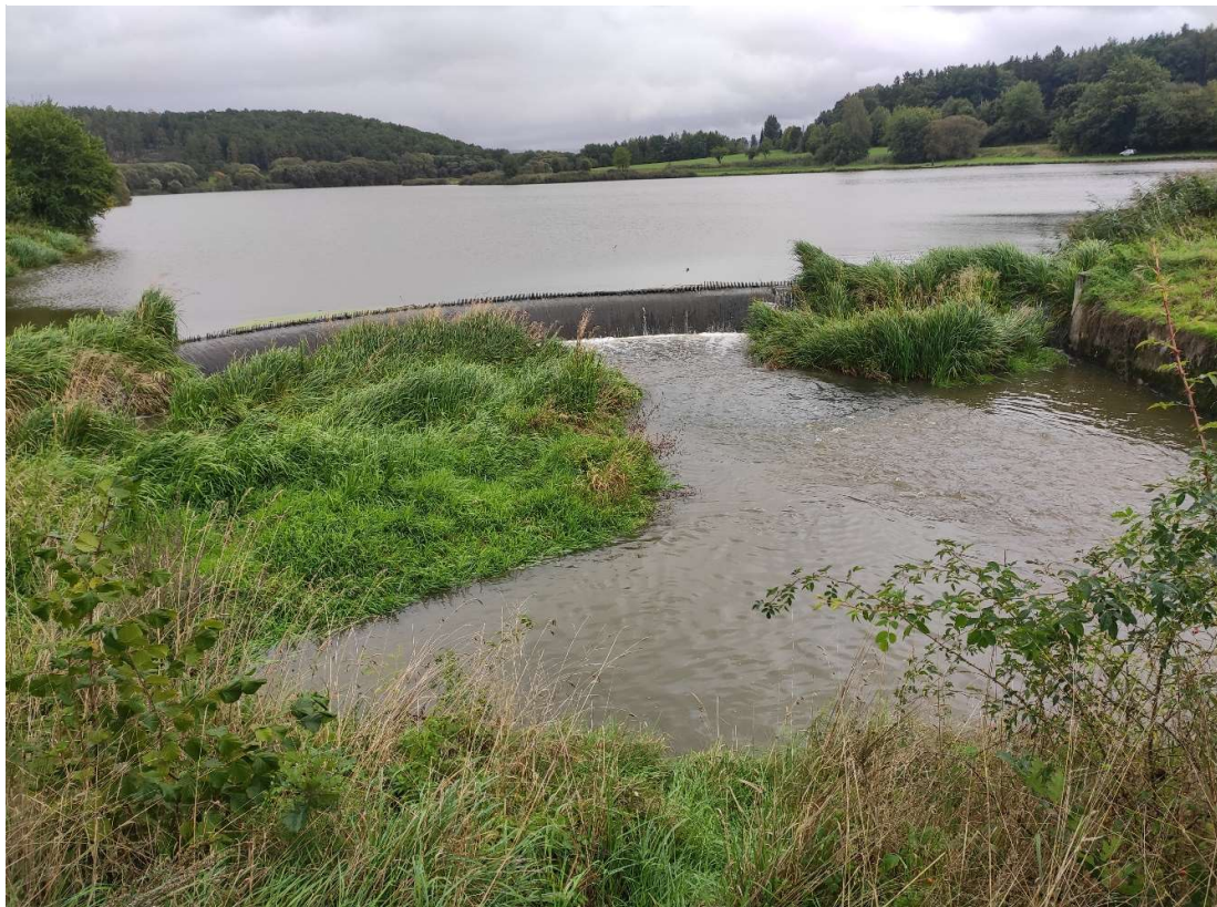
Obr. č. 3 - Pohled na bezpečnostní přeliv z pravého zavázání, foto: Aneta Řeháková, 19.9.2022
