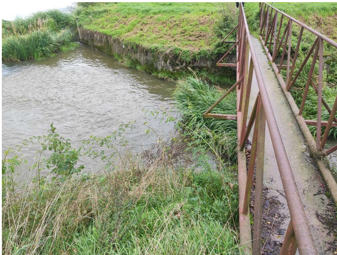
Obr. č. 4 - Zatopený vývar od bezpečnostního přelivu, foto: Aneta Řeháková, 19.9.2022
