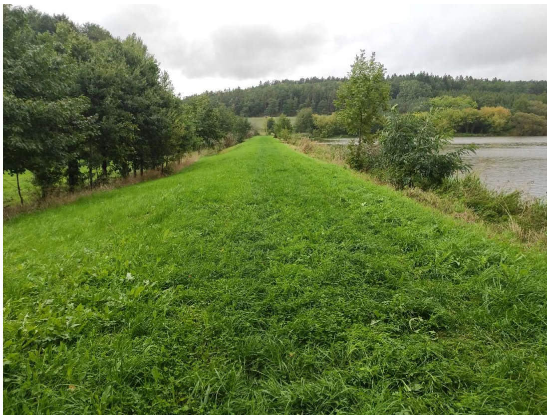
Obr. č. 1 - Pohled na korunu hráze z levého zavázání, foto: Aneta Řeháková, 19.9.2022
