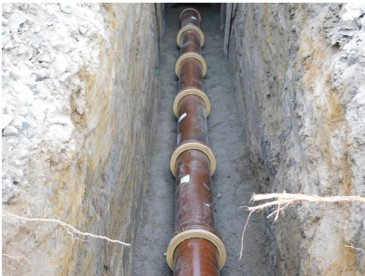
Obrázek 5 – Uložení kanalizace [24]
