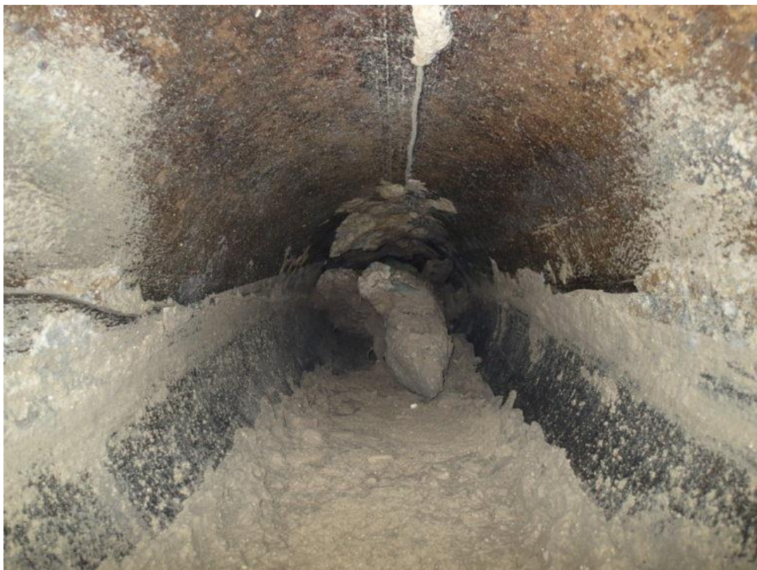
Obrázek 14 – Zanesená stoka [47]
