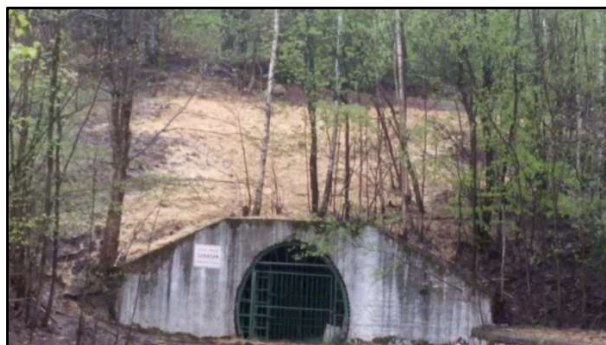
Obrázek 33: Vstup do štol
