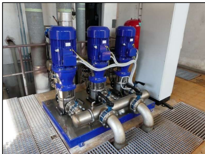
Obrázek 21: Příklad zapojení automatické tlakové stanice [10]
