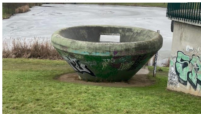
Obrázek 3- Bezpečnostní přeliv kašnový, retenční nádrž Asuán
