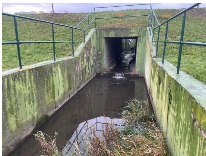
Obrázek 9- Sdružený objekt- odpadní koryto
