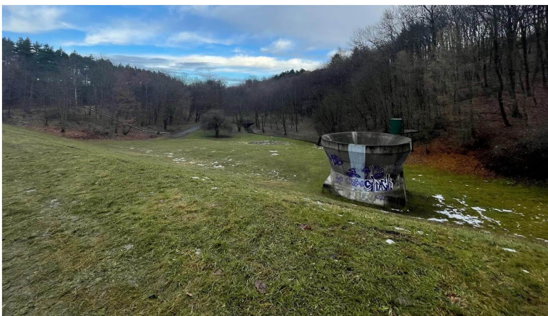
Obrázek 4- Suchá retenční nádrž N4 Jionice
