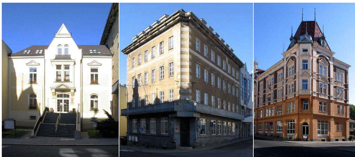
Obrázek 7 – Budovy A/B/C městského úřadu Rumburk
