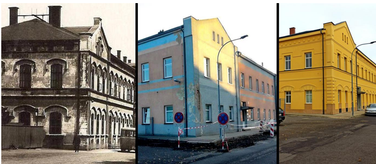
Obrázek 5 – Budova hlavního nádraží Rumburk – historická/před rekonstrukcí/po rekonstrukci
