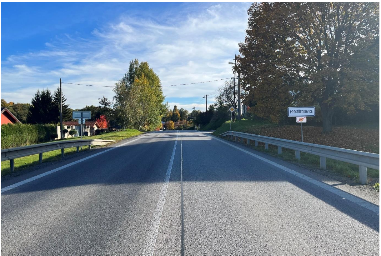
Obrázek 38 - Pohled na vjezd do obce Prostředkovice ze směru od obce Jihlava [Zdroj: archiv autora]
