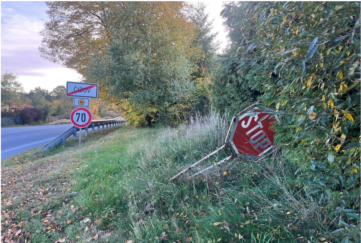
Obrázek 17 – Pohled na poškozené SDZ u výjezdu ze západního vedlejšího ramene křižovatky 5 na silnici I/38 v obci Čížov [Zdroj: archiv autora]
