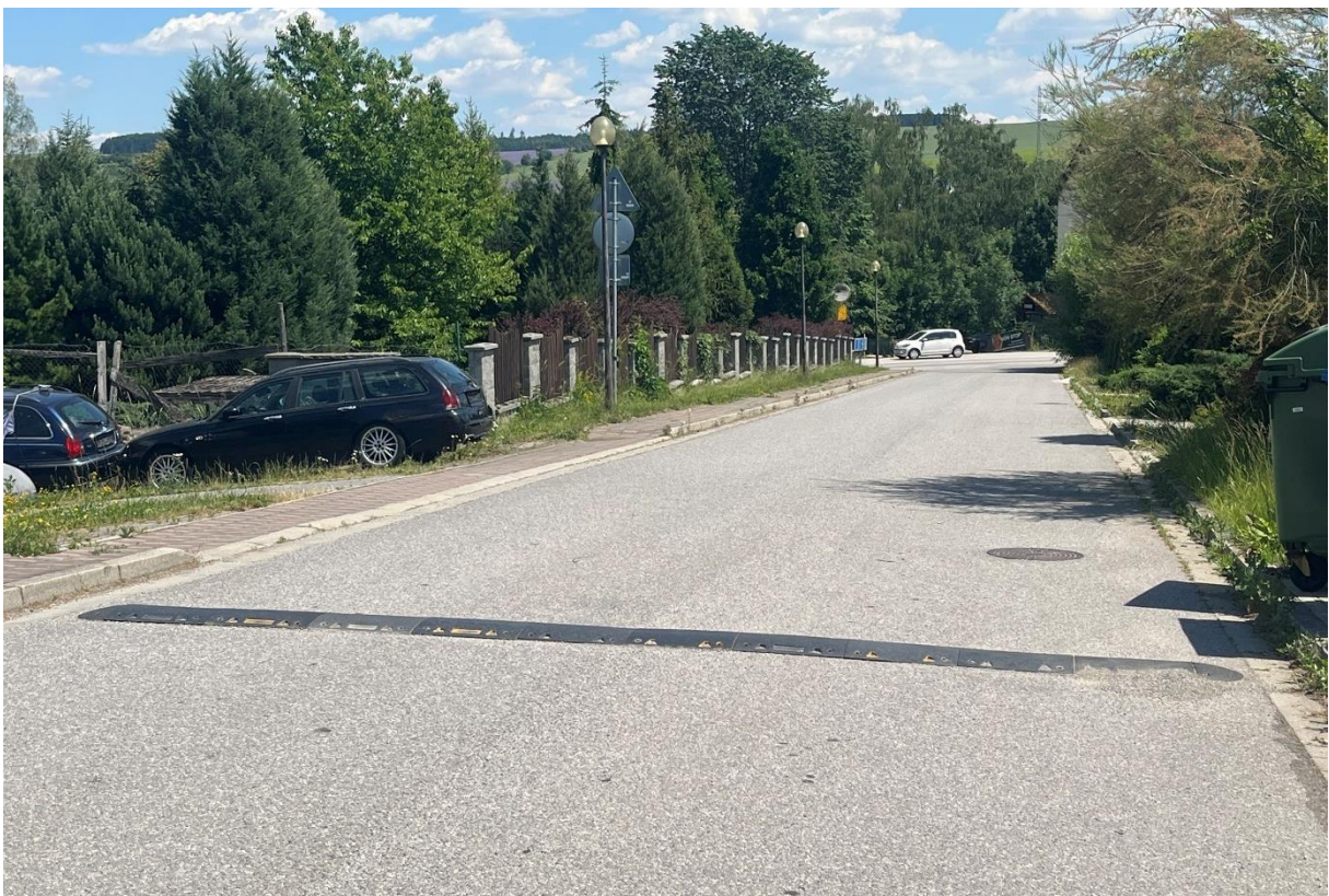
Obrázek 18 – Pohled na krátký zpomalovací práh na západním rameni průsečné křižovatky 5 v obci Čížov [Zdroj: archiv autora]
