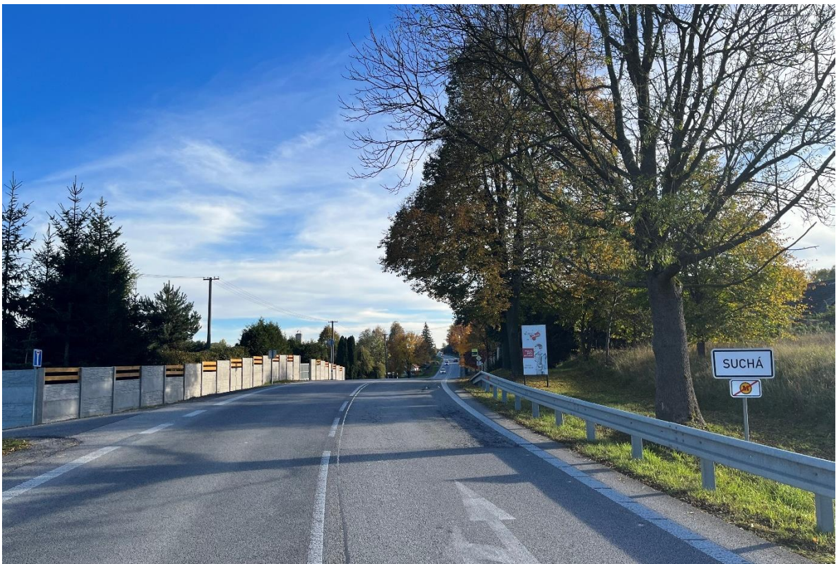
Obrázek 34 - Pohled na vjezd do obce Suchá ze směru od obce Jihlava [Zdroj: archiv autora]
