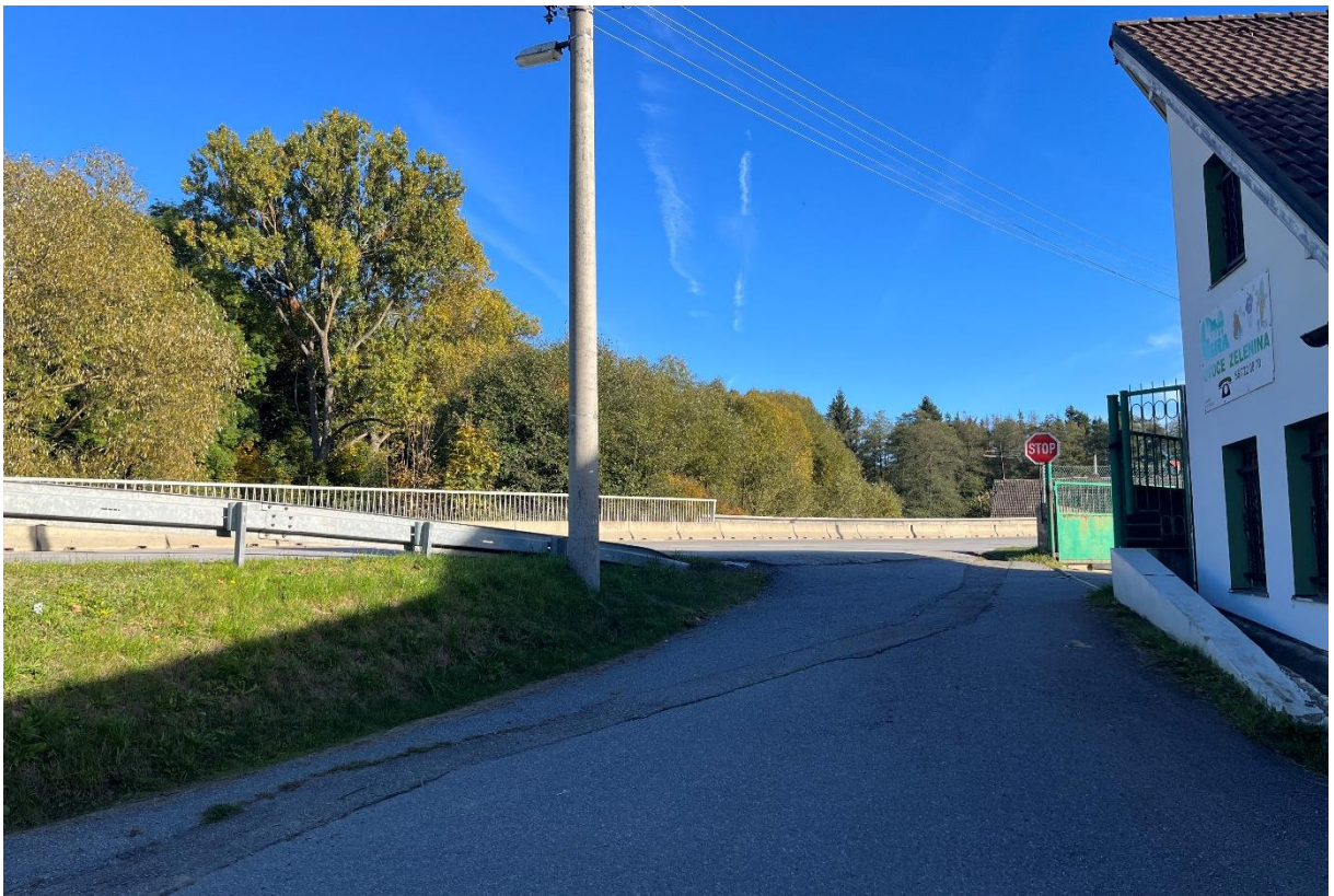
Obrázek 44 – Pohled vedlejšího ramene stykové křižovatky 12 na napojení silnice I/38 v obci Prostředkovice [Zdroj: archiv autora]
