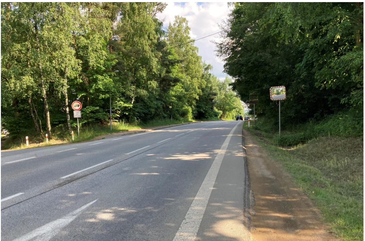
Obrázek 4 – Pohled ze západního ramene na vyjetou nebezpečnou krajnici u silnici I/38 z důvodu odbočování vlevo do východního ramene odsazené křižovatky 2 v obci Rančívov [Zdroj: archiv autora]
