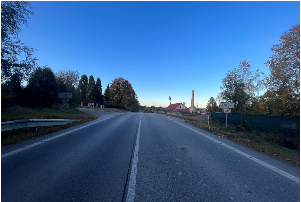
Obrázek 19 - Pohled na vjezd do obce Čížov ze směru od obce Stonařov [Zdroj: archiv autora]
