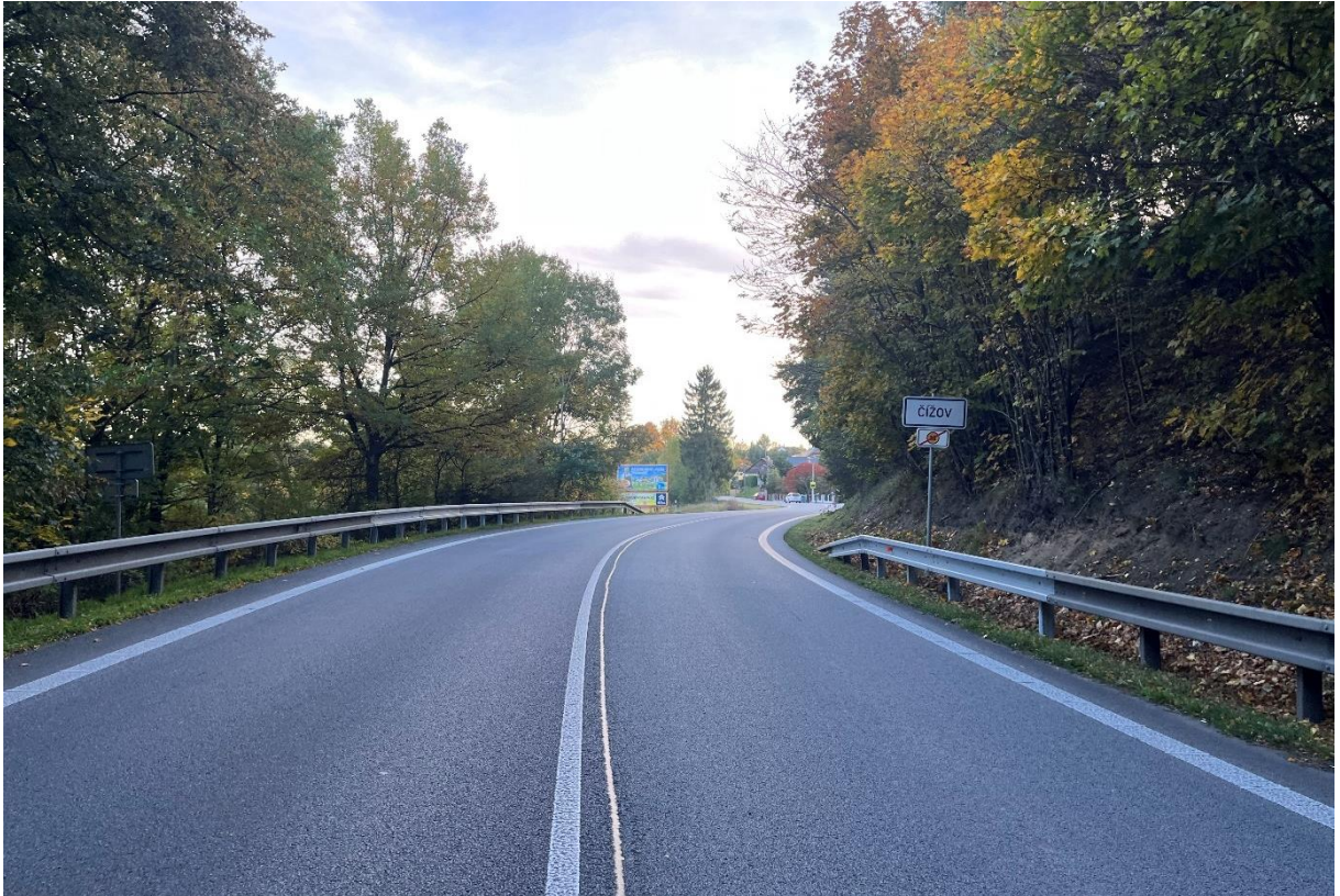
Obrázek 11 - Pohled na vjezd do obce Čížov ze směru od obce Jihlava [Zdroj: archiv autora]
