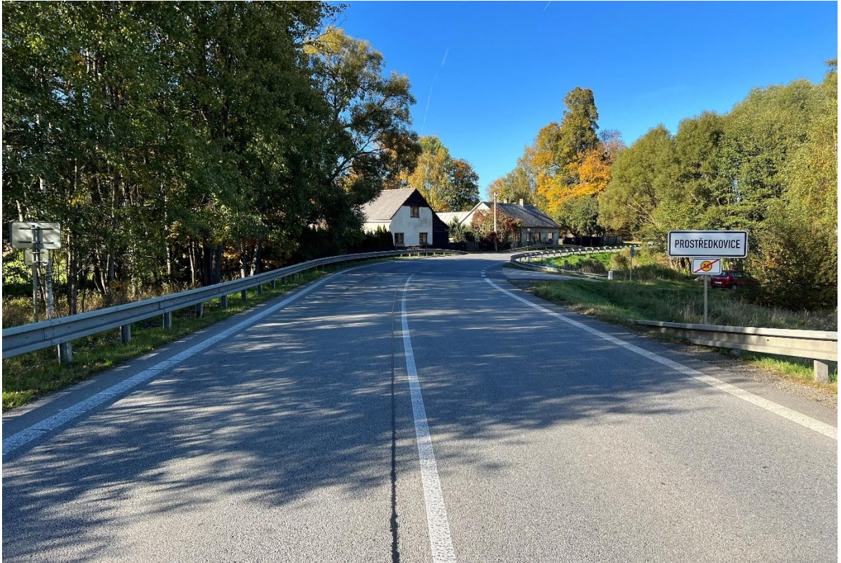
Obrázek 45 – Pohled ze silnice S I/38 směr obec Jihlava na vjezd do obce Prostředkovice
