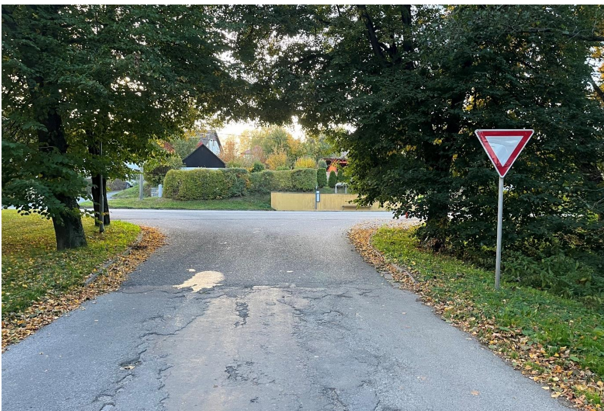
Obrázek 14 – Pohled ze silnice III/03827 na napojení silnice I/38 křižovatky 4 v obci Čížov [Zdroj: archiv autora]
