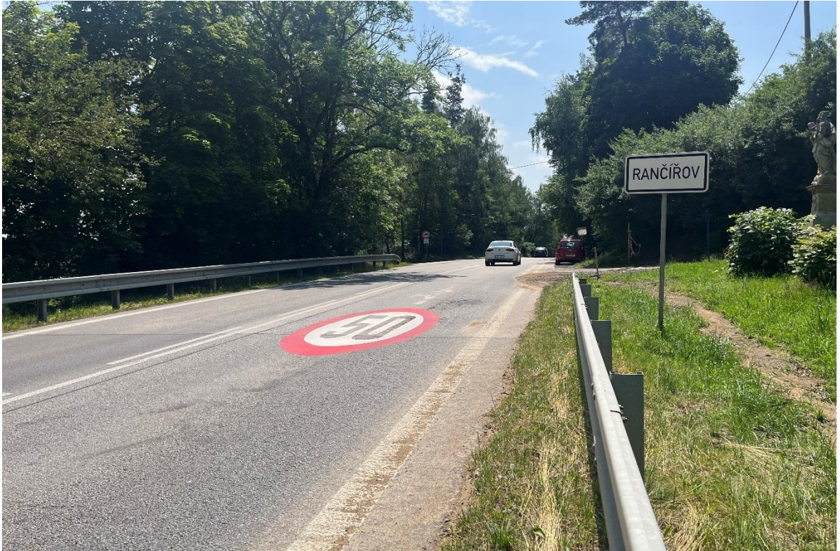
Obrázek 3 - Pohled na vjezd do obce Rančívov ze směru od obce Jihlava [Zdroj: archiv autora]
