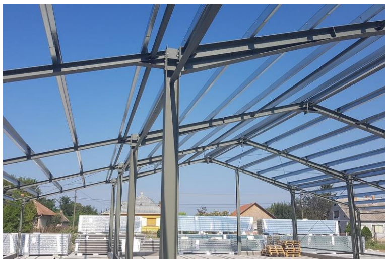
Obrázek 2: Konstrukce haly z tenkostěnných profilů [3]
