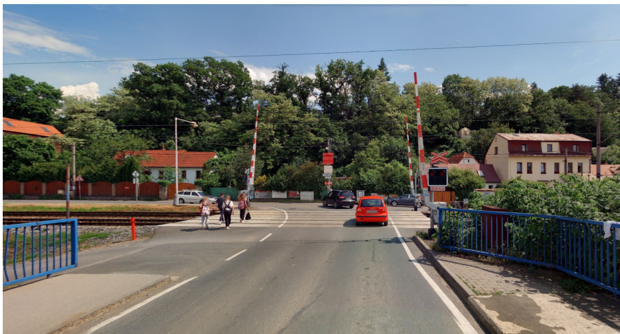
Obrázek 2.20: Železniční přejezd x most
