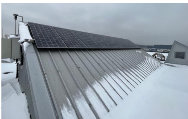
Obrázek 35: Solární moduly (245 W) na světlíku UCEEB
