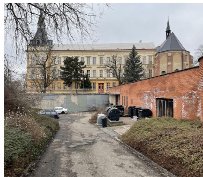
Vjezd do garáží bytového domu Eliška
