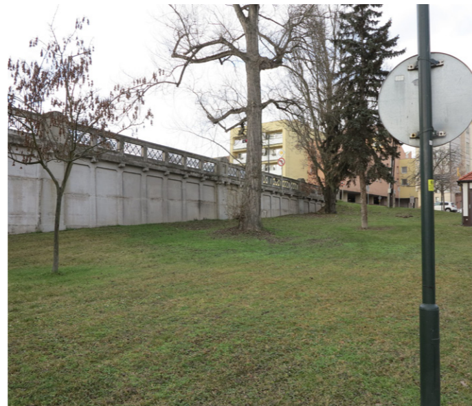
Strana mostu směrem k plánovanému vjezdu.
