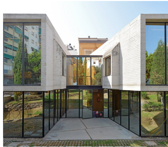
Pohled na jeden z vchodů do budovy [19]
