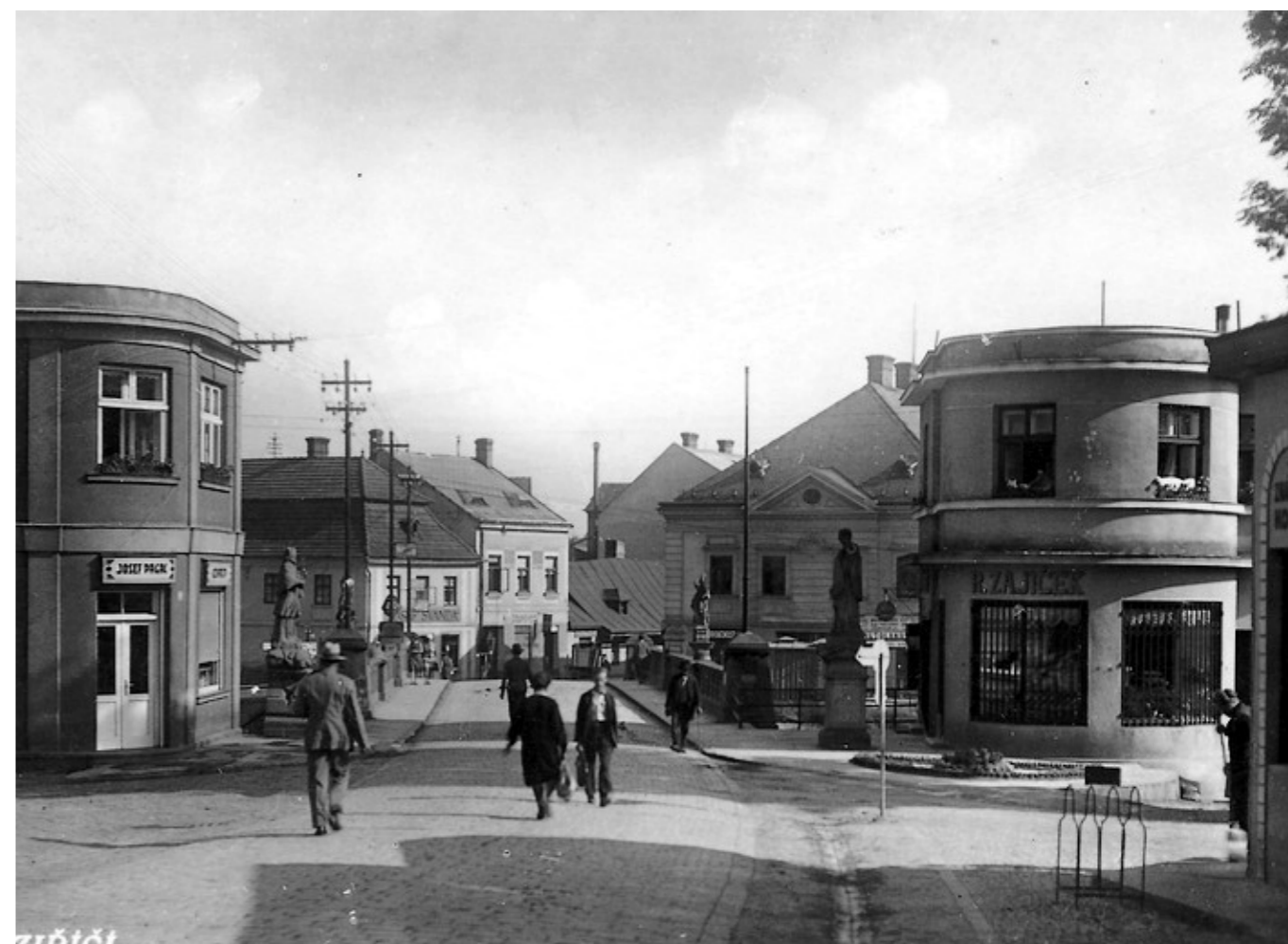
(1) (2) - pohled z náměstí na ulici Mostní
