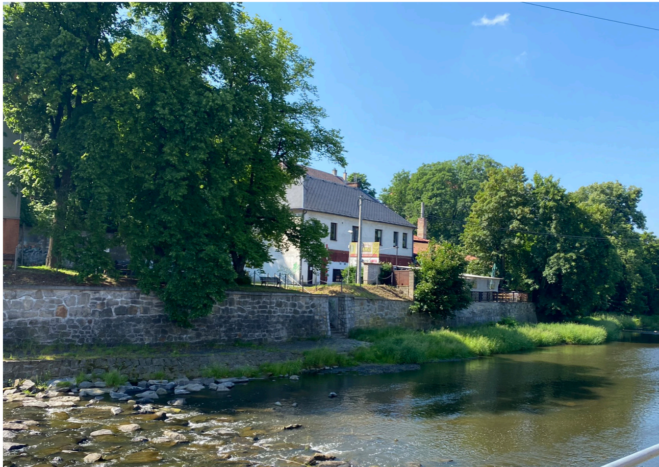
Zdroj: vlastní fotografie - stávající stav
