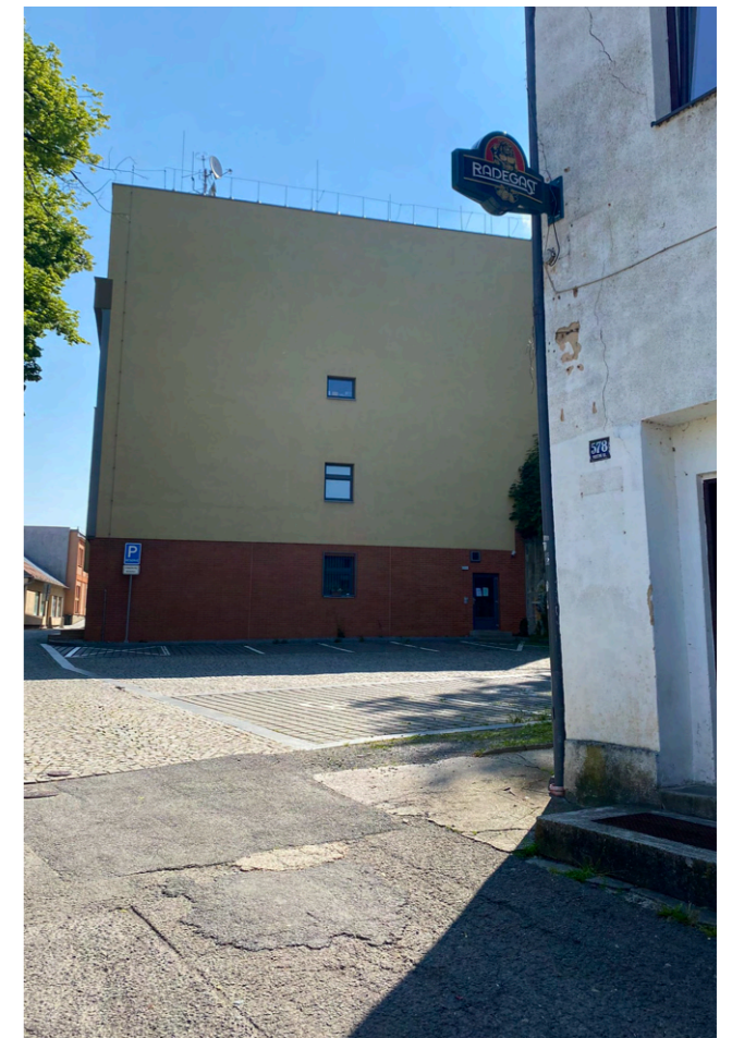
Zdroj: vlastní fotografie - stávající stav
