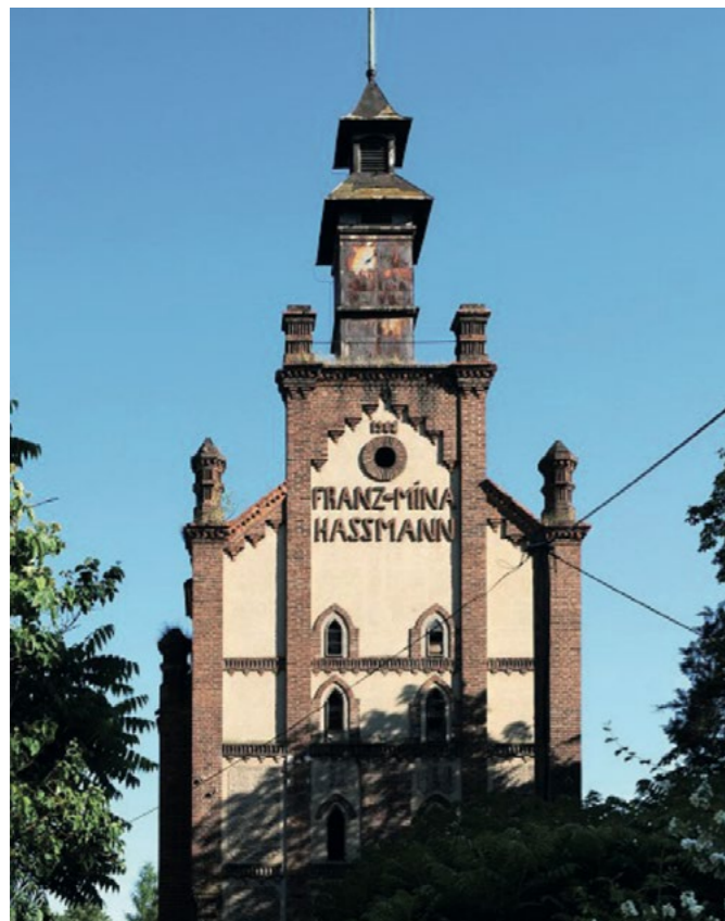
POHLED SEVERNÍ ZDROJ: EFLER, 2018
