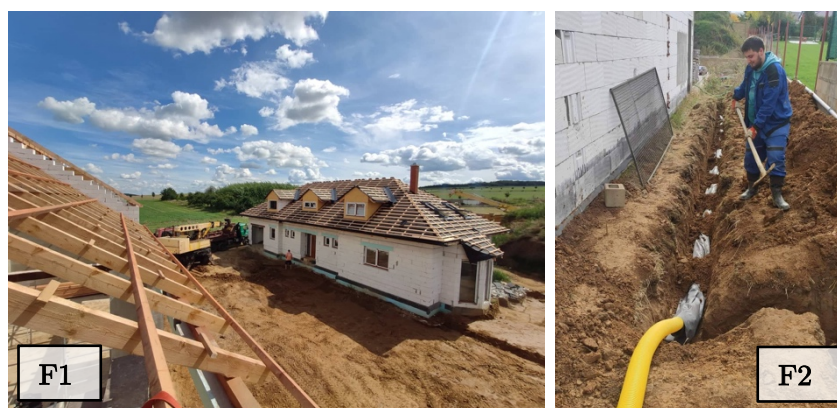
Obr. 3.12.: Stavba v Červených Pečkách a drenážní systém, pohled F1 a F2
