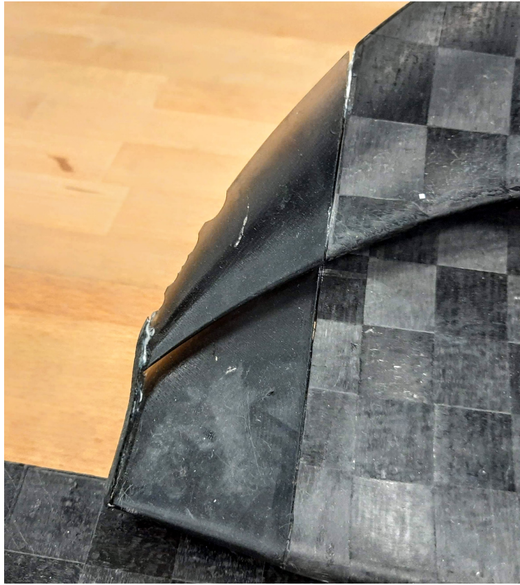
Obr. 52: Detail poničené odtokové hrany
