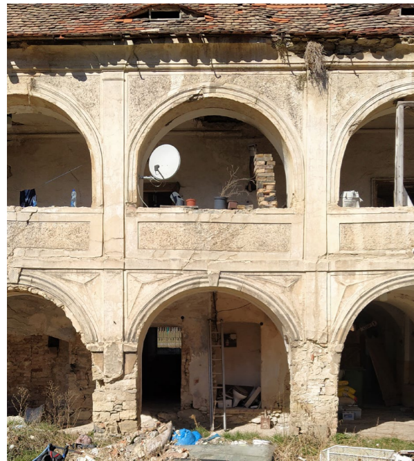
arkády v nádvoří, současný stav (archiv autora)
