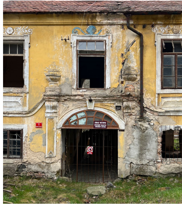
vstupní portál, současný stav (archiv autora)
