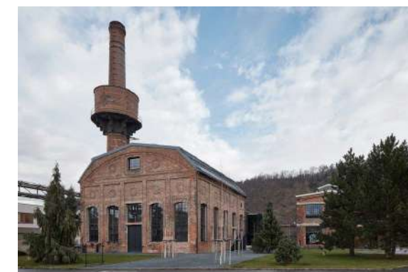
R34 - Malá hala - Kotelna v Libčicích nad Vltavou
