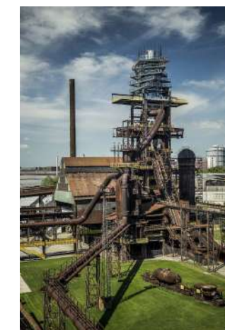
R37 - Výstup na chladicí věž - Bolt tower Vítkovice
