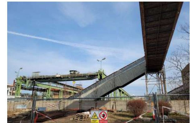
Jeřábová dráha a přechod přes ulici
