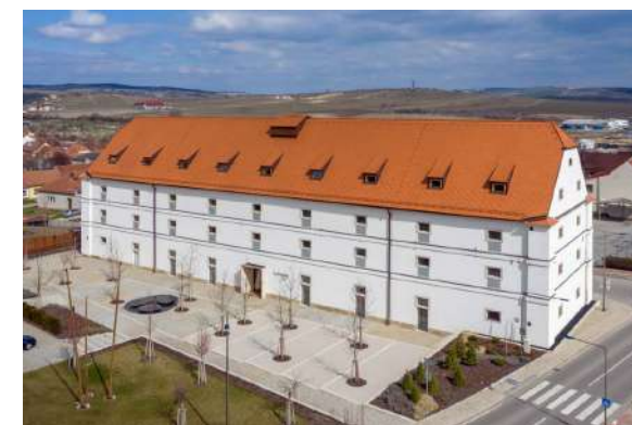
R49 - Bývalá sýpka Hotel Lotrinský Velké Pavlovice
