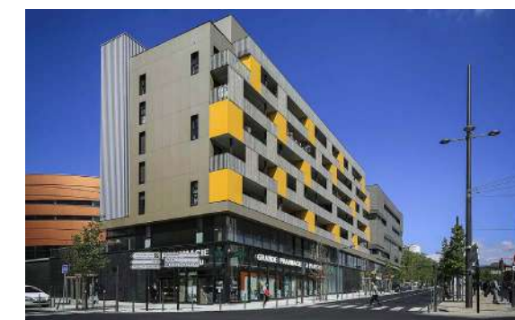
R9 - Block 32, edificio de viviendas en Lyon
