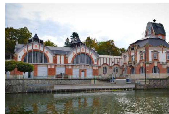
Vodní elektrárna Hučák
