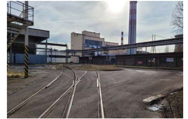
Vlečky u budovy elektrárny Opatovi- ce
